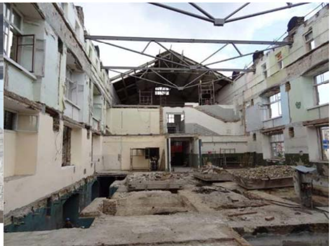
Рис. 11. Фото процесу демонтажу внутрішніх конструкцій будівлі ДМС
