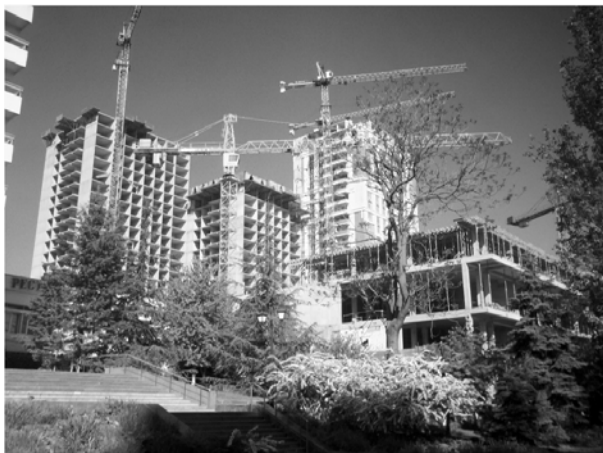
Рис. 7. Загальний вигляд каркасу секцій житлового комплексу
