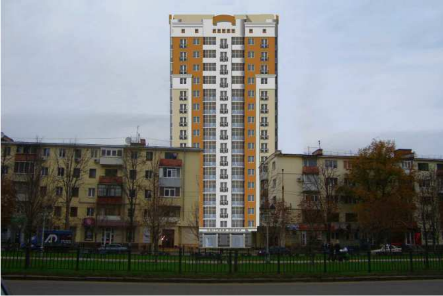
Рис. 5. Житлова 16-ти поверхова будівля системи «КУБ» після зведення в м. Полтава
