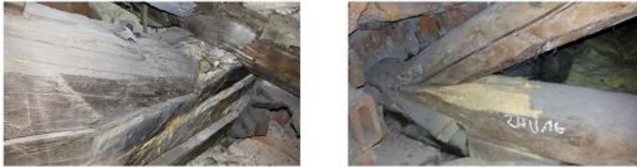
Рис. 1,2. Ураження гниллю опорних вузлів ферм
