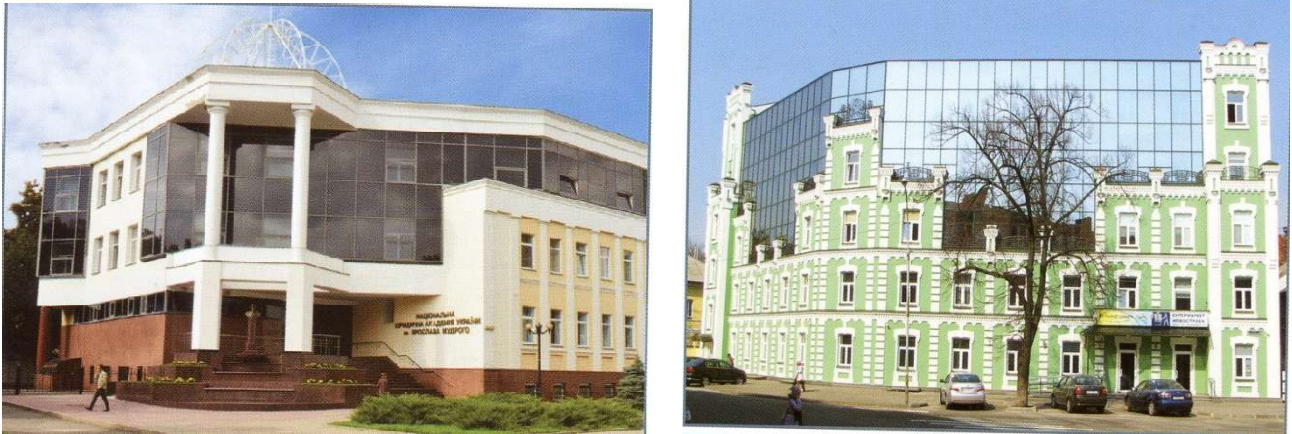
Рис. 2. Юридичний коледж на Першотравневому проспекті, 14 та офіс-центр на місті колишнього радіовузла на вул. Стрітенській, 36 [1]
