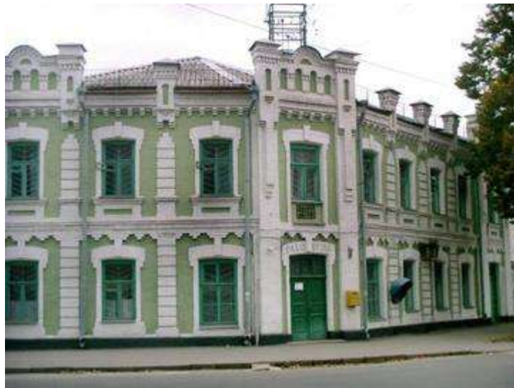
Рис. 3. Будівля радіовузла до реконструкції, побудовано 1896 р., 1920 р. обладнано під радіовузол
