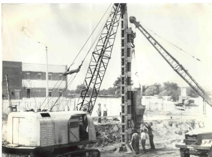
Рис. 8.3 – Агрегат для пробивання свердловин на базі екскаватора-драглайна Е-10011
