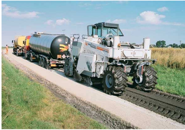
Рисунок 2 – Відновлення дорожнього одягу з використанням ресайклера Wirtgen WR2500S
