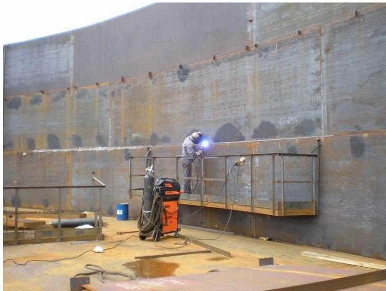
Рис. 10.6. Полистовий монтаж резервуарів
