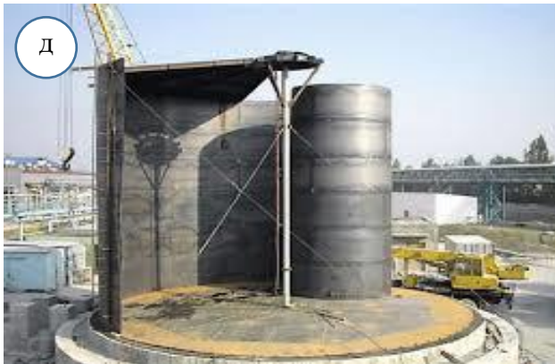
Рис. 10.7. Монтаж вертикального резервуару методом рулонування
