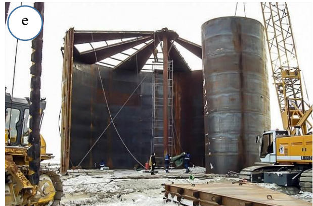
Рис. 10.7. Монтаж вертикального резервуару методом рулонування
