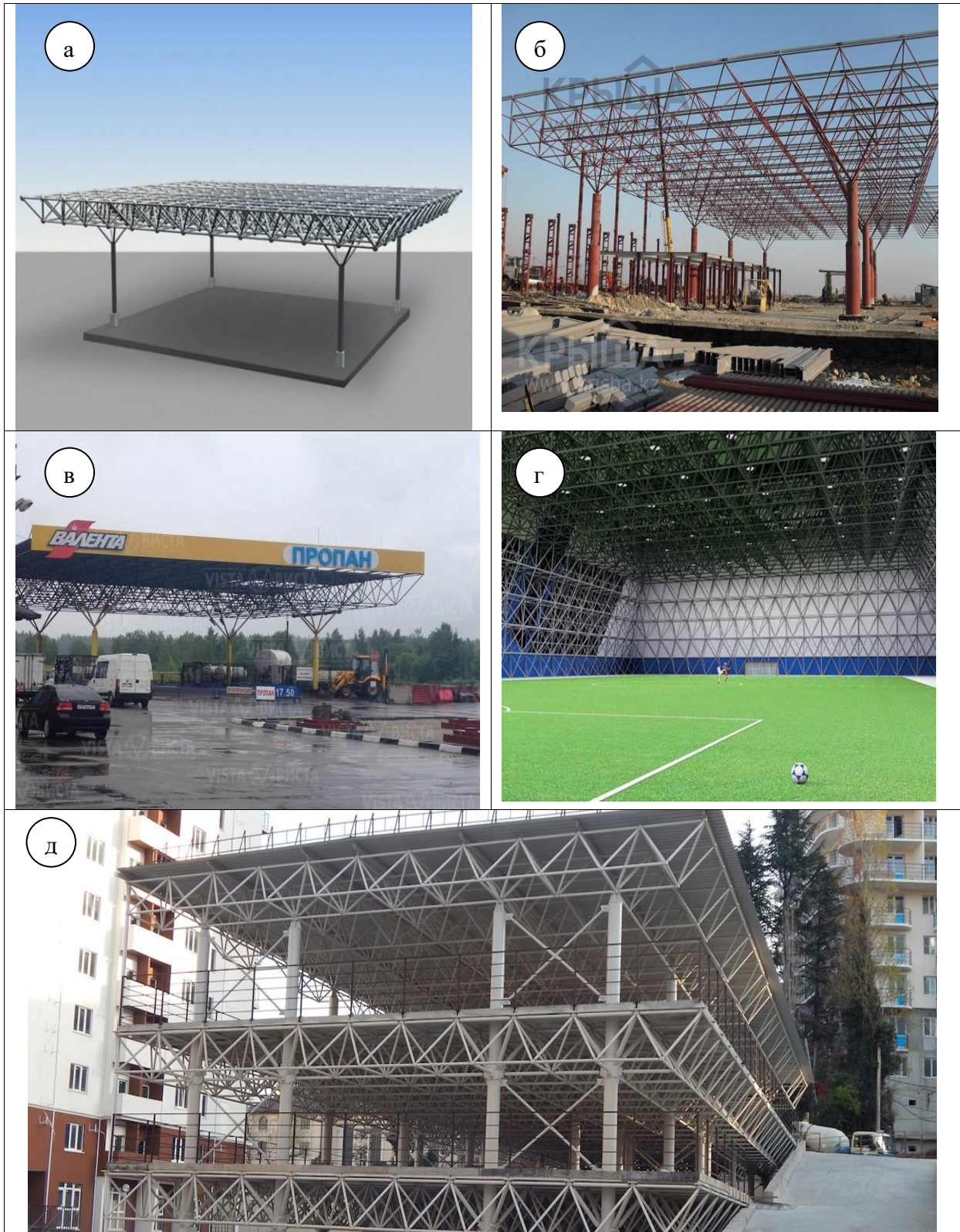
Рис. 9.36. Приклади плоских структурних конструкцій: а – модель структурного покриття; б – змонтоване структурне покриття; в – структурне покриття АЗС; г – структурні конструкції спортивного залу д – багатоповерхова будівля із структурними перекриттями
