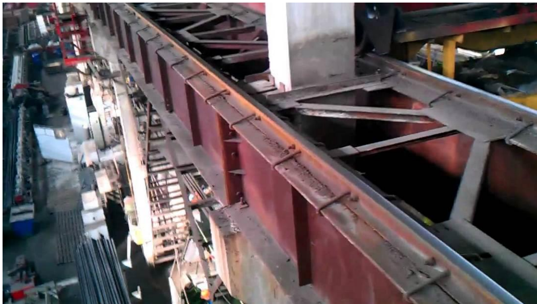
Рис. 8.7. Підкранові балки з гальмівною фермою
