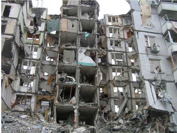
Рисунок 1 – Наслідки вибуху газу у житловому будинку у м. Дніпро
