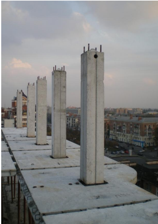
Рисунок 1.2 – Фрагменти спирання надколонних плит на колони 16-ти поверхової будівлі безконсольно-безкапітельно-безбалкової конструктивної системи
