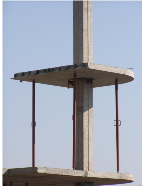
Рисунок 1.2 – Фрагменти спирання надколонних плит на колони 16-ти поверхової будівлі безконсольно-безкапітельно-безбалкової конструктивної системи
