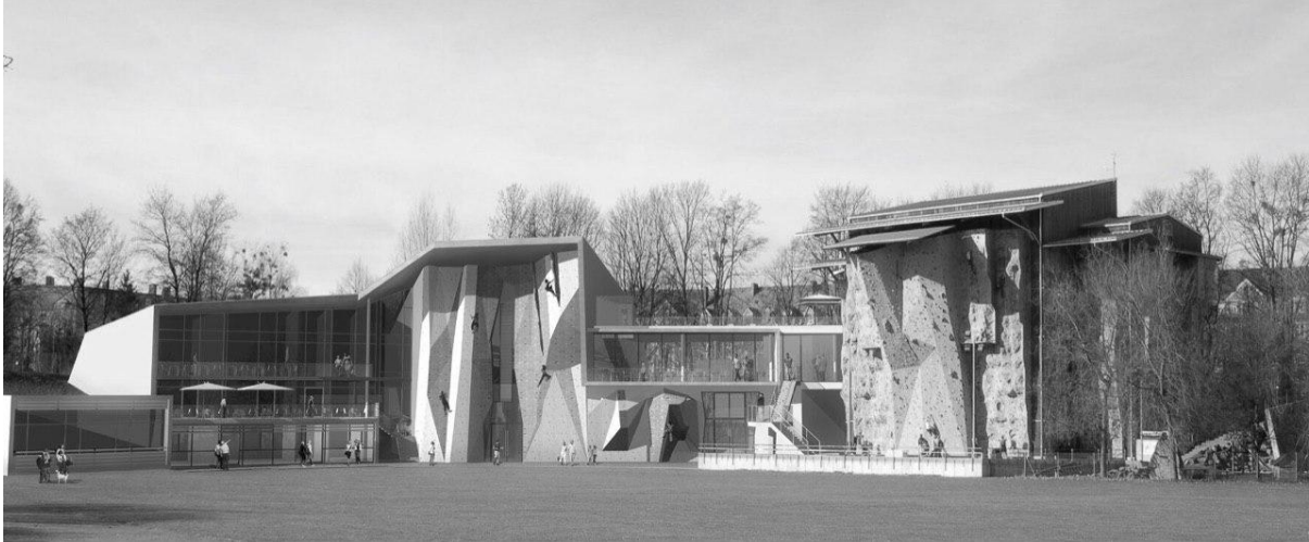
Рис. 1. Приклад влаштування прибудованого скеледрому на макеті "Центру лазання Мюнхена" (Kletterzentrum München), Німеччина
