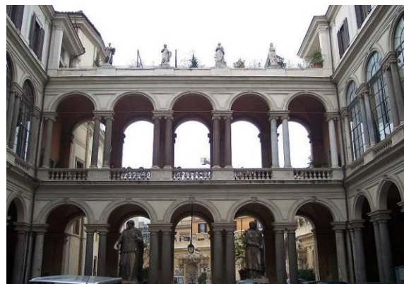
Рис. 3.2.18. Внутрішній двір палаццо Боргазе
