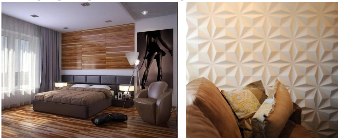
Рис. 6.1.19. Оздоблення стін фанерними та 3D-панелями
