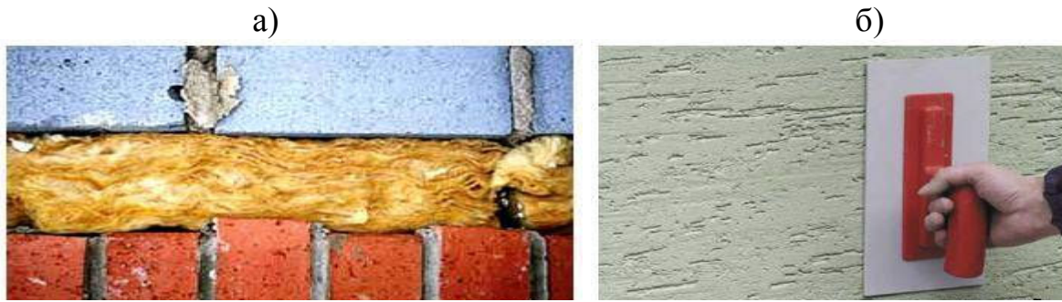
Рис. 1 – Енергозберігаючі матеріали: а) мінеральна вата; б) енергозберігаюча штукатурка
