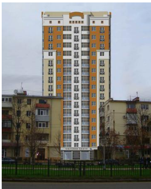
Рисунок 2 – Общий вид жилых 16-ти этажных зданий бескапитально-безбалочной каркасной конструктивной системы в г. Полтава в процессе возведения и перед вводом в эксплуатацию
