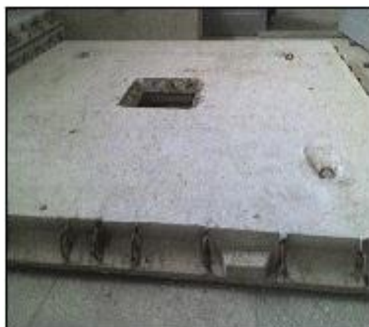
Рисунок 4 – Расположение арматуры надколонной плиты в опалубке и общий вид надколонной плиты после бетонирования
