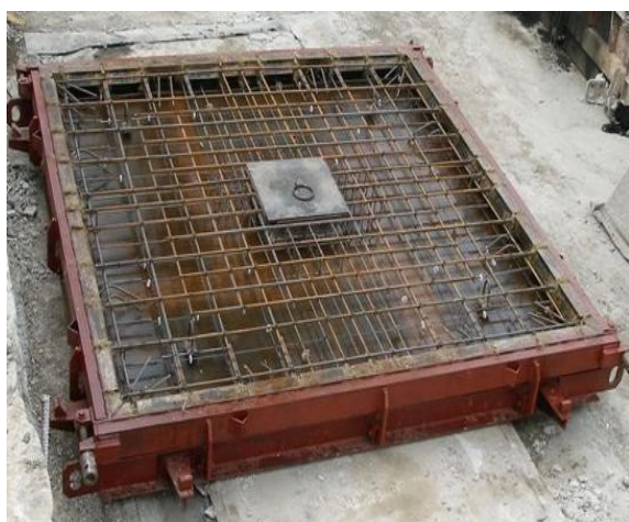
Рисунок 4 – Расположение арматуры надколонной плиты в опалубке и общий вид надколонной плиты после бетонирования
