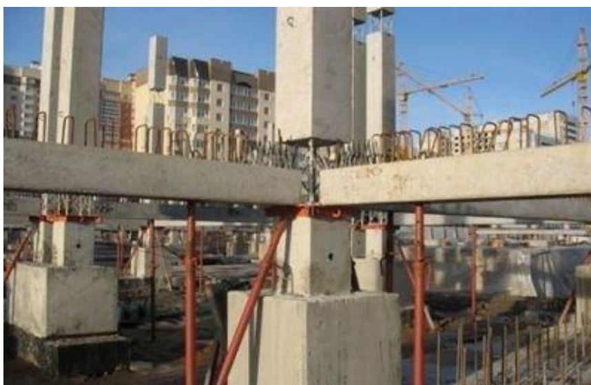
Рисунок 1. 23 – Вузол з'єднання ригеля з колоною
