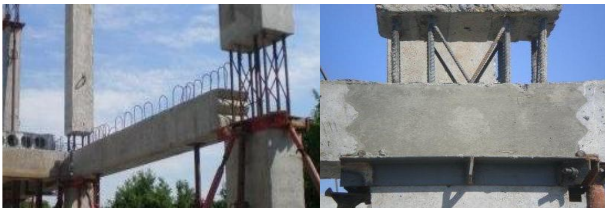
Рисунок 1.10 – Фрагменти монтажу збірних ригелів системи «Казань-XXI в» ( a ) та їх з'єднання з колоною ( б )
