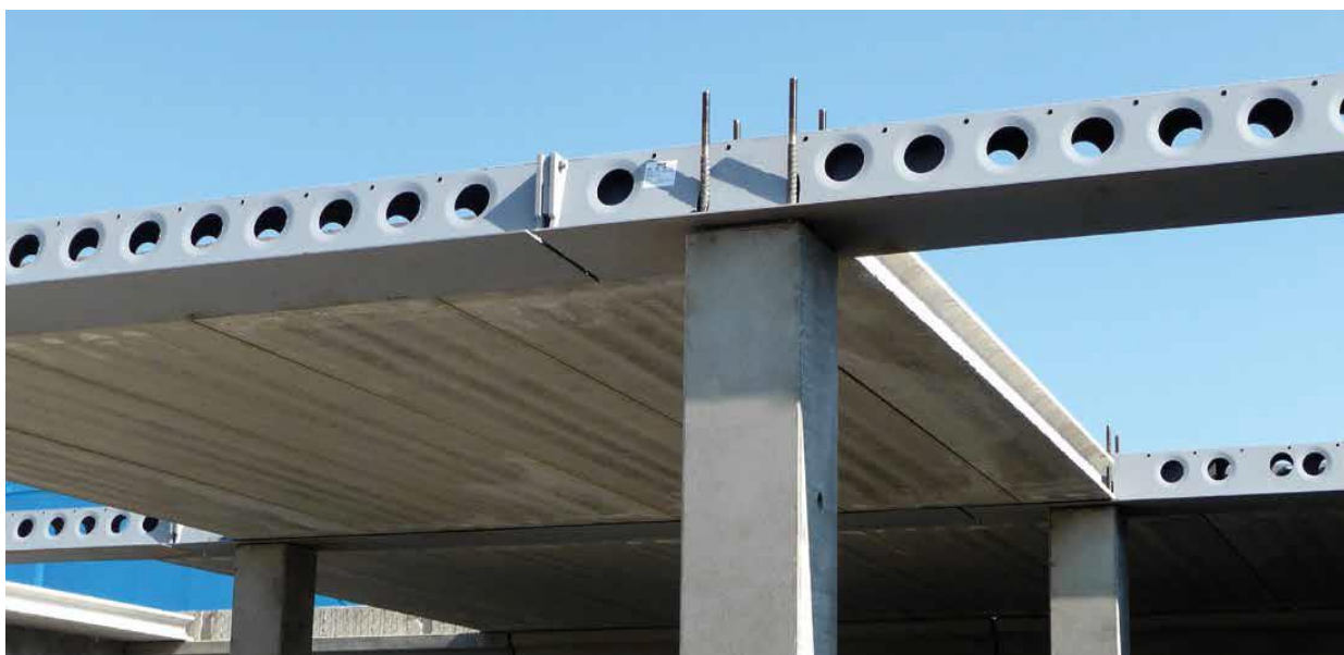
Рисунок 1.2 – Збірно-монолітний каркас Delta в процесі зведення
