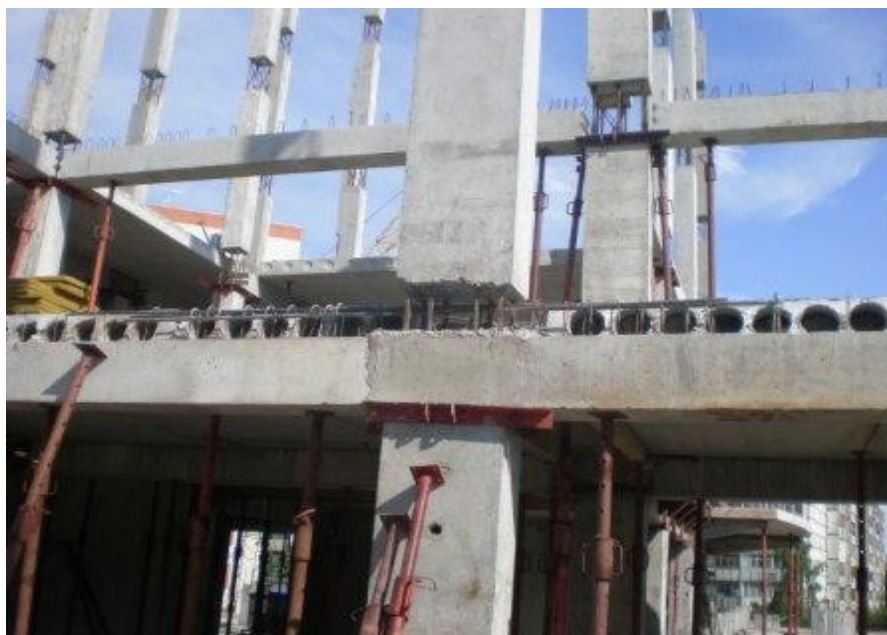
Рисунок 1.12 – Будівля конструктивної системи «Казань – XXI в» у процесі зведення
