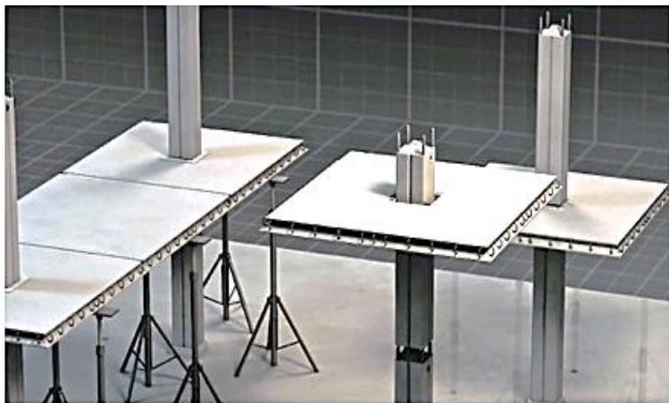
Рисунок 5.4 – Монтаж плит перекриття
