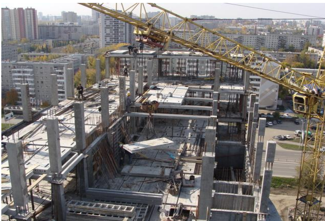
Рисунок 1.18 – Загальний вигляд каркасу конструктивної системи «УДС» у процесі зведення
