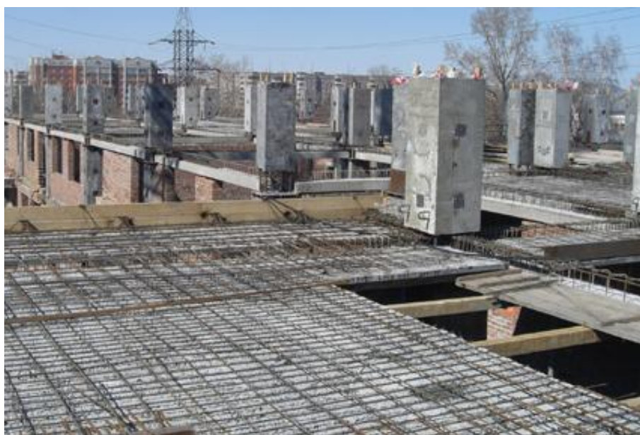
Рисунок 1.24 – Загальний вигляд будівлі, що зводиться за конструктивною системою «Рекон»
