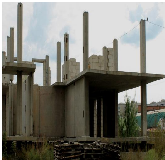
Рисунок 1.33 – Фрагмент житлового 16-ти поверхового будинку в процесі зведення по вул. Боровиковського, 11 в м. Полтава
