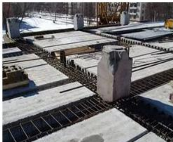
Рисунок 1.8 – Перекриття будівлі конструктивної системи «АРКОС» у процесі зведення
