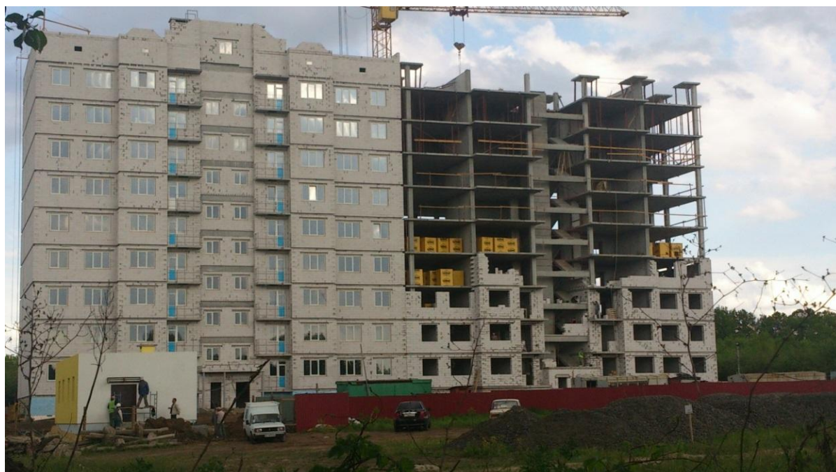
Рисунок 1.34 – Будівля в процесі зведення в житловому мікрорайоні «Садовий» у с. Розсошенці (2014 – 2015 рр.)
