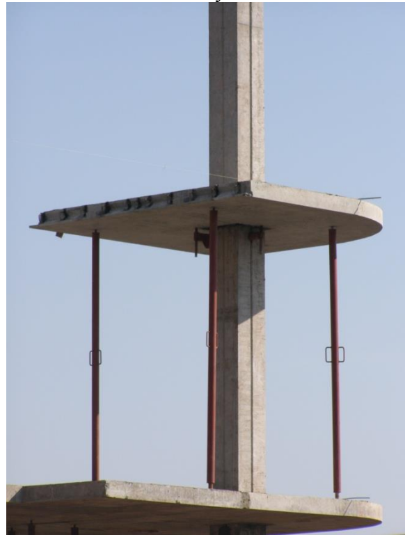
Рис. 1. Фрагменти спирання надколонних плит на колону 16-ти поверхової будівлі безкапітельно-безконсольно-безбалкової конструктивної системи.
