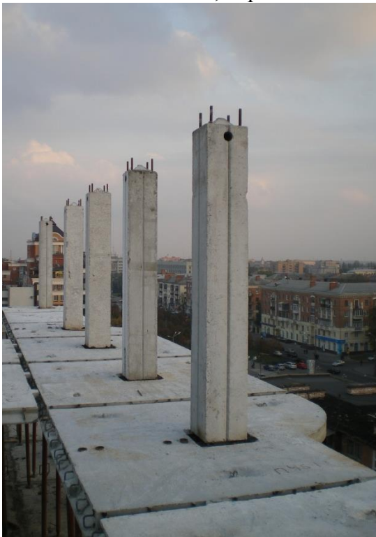
Рис. 1. Фрагменти спирання надколонних плит на колону 16-ти поверхової будівлі безкапітельно-безконсольно-безбалкової конструктивної системи.
