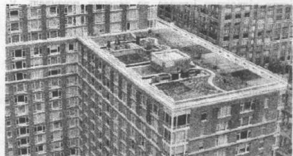
Рис. 3. Екстенсивна зелена покрівля на плоскому даху / Extensive green roof on the flat roof
