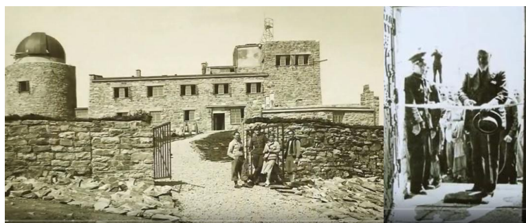
Рис. 3. Первинний вигляд новозбудованої обсерваторії на горі Піп Івані та її урочисте відкриття
