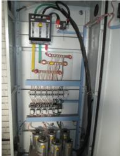
Рис. 5. Установка КРП з контролером ЕТІ
