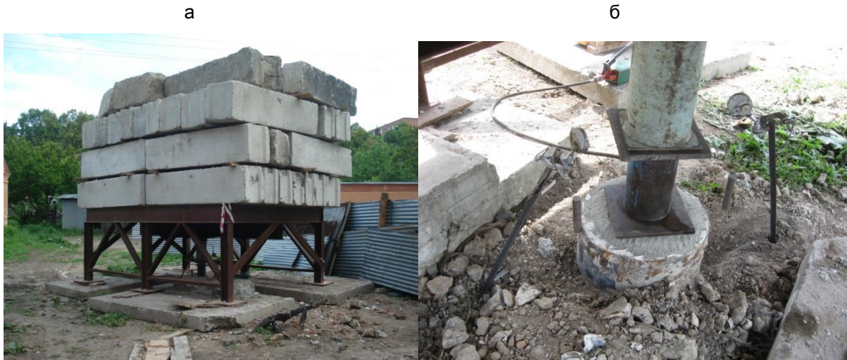
Рис. 3.12 – Обладнання, використане при статичних випробуваннях армованих ґрунтоцементних паль: а – вантажна платформа б – деталь спірання гідравлічного домкрату на голову ґрунтоцементної палі
