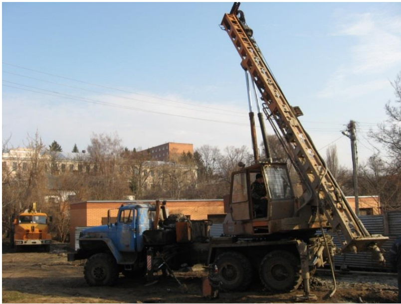
Рис. 3.7 – Дослідні виготовлення ґрунтоцементних палів
