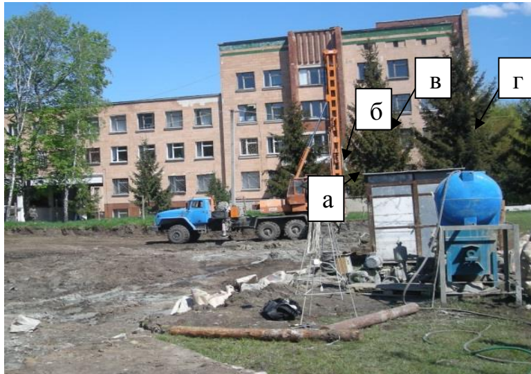
Рис. 1.3 – Загальний вигляд комплексу обладнання для виготовлення ґрунтоцементних елементів за бурозмішувальною технологією: а – буровий верстат; б – схованка для розчиномішалки, розчинонасосу, склад цементу; в – ємність води; г – напірний шланг
