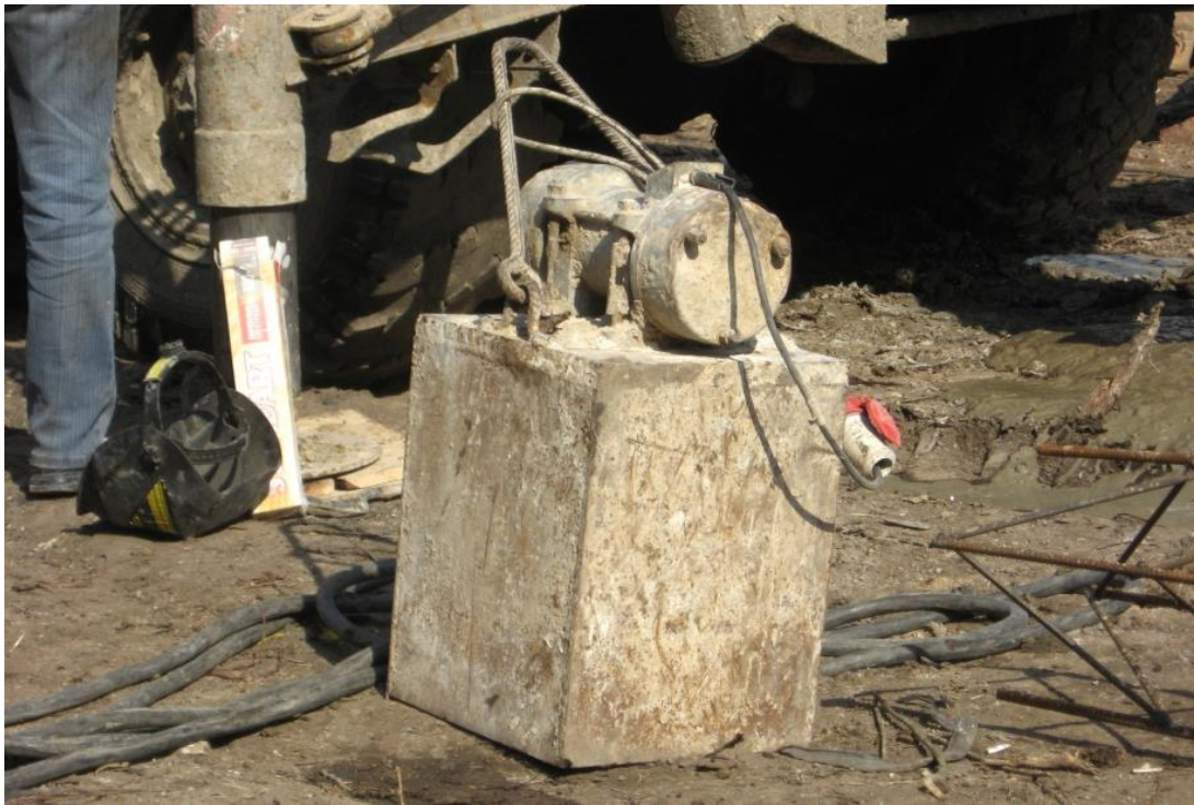
Рисунок 3.9 – Вібратор для заглиблення арматурного каркасу
