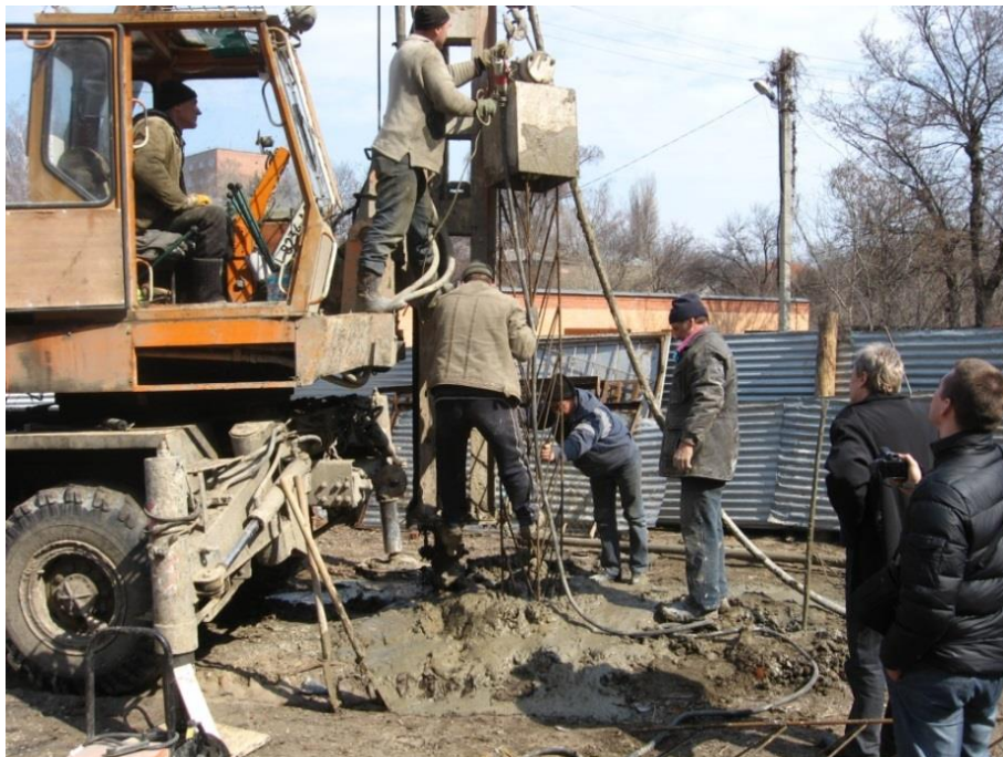
Рис. 3.8 – Поміщення каркасу в тіло дослідної ґрунтоцементної палі
