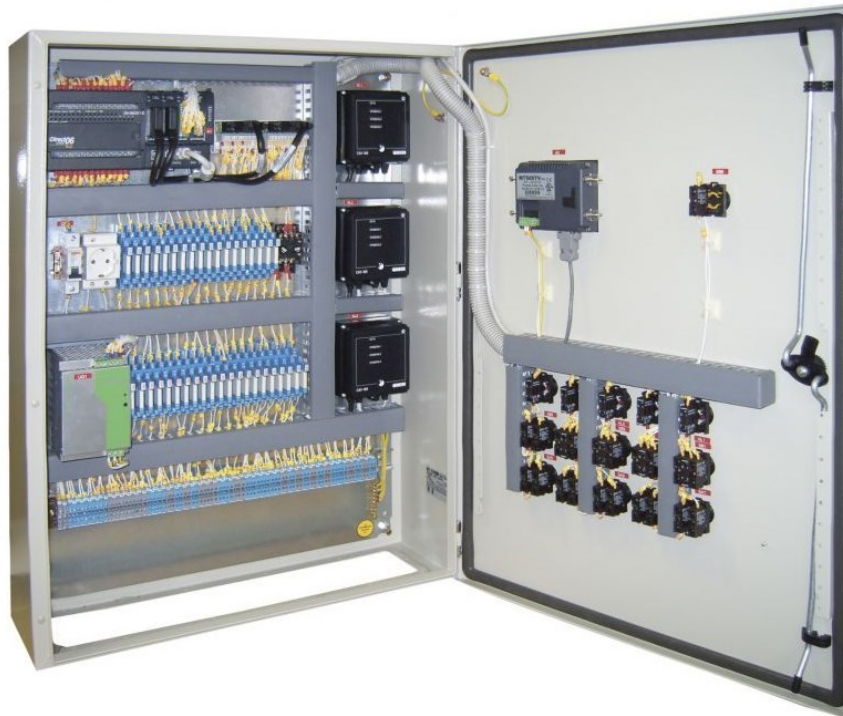
Рис. 4.6 – Шафа керування «ЮГШУНС» з перетворювачем частоти Функції шафи управління з частотним регулюванням:
