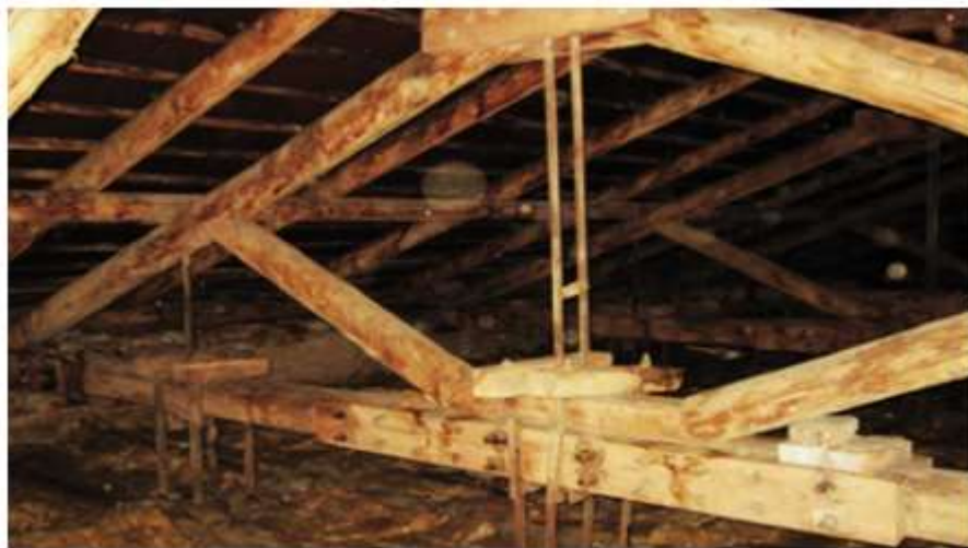
Рис. 3 – Характерні пошкодження крокв
