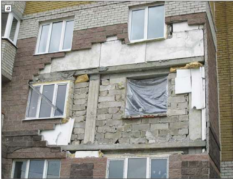
Рис. 8 – Пошкодження зовнішніх стін
