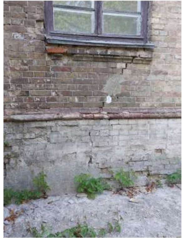
Рис. 10 - Характерні пошкодження огорожень будівель
