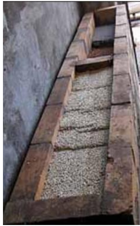
Рис. 16 – Ущільнена ПВС на основі вермікуліту. На задньому плані – ущільнений татарський вермікуліт з протипожежним розсіченням
