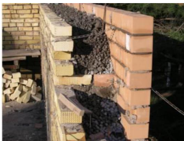
Рис. 14 – Зовнішня стіна котеджу виконана в кладці колодязя з внутрішнім шаром з великопористого керамзитобетону у стадії будівництва
