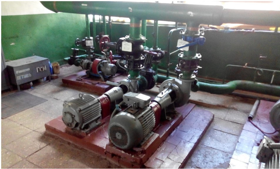
Рисунок 2.4 – Мережеві насоси
