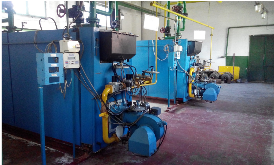
Рисунок 2.3 – Котли ВК-32-1,5
