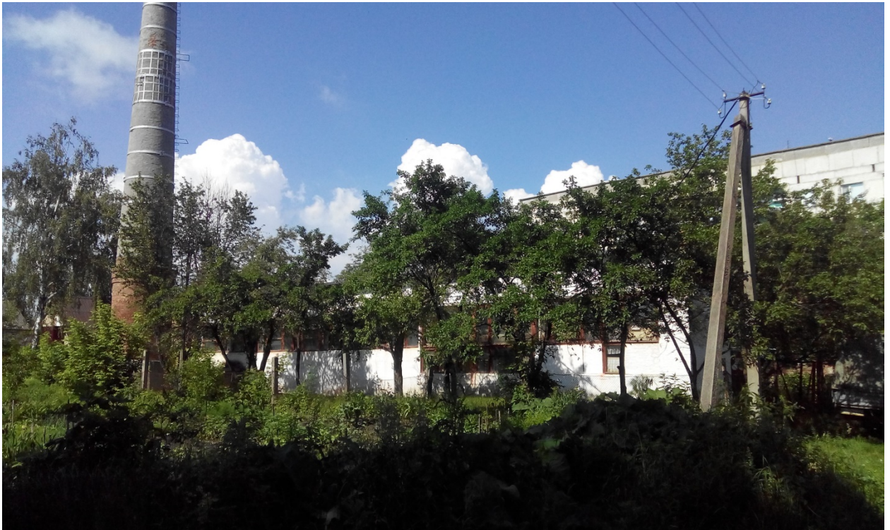
Рисунок 2.1 – Загальний вигляд котельні
