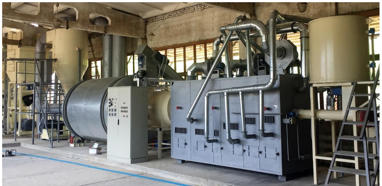
Рисунок 4 – Загальний вигляд технологічного обладнання з переробки соняшникового лушпиння на ВІОsmartex
