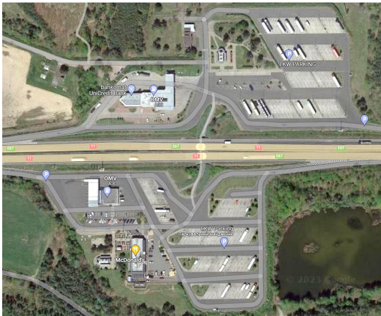
Рисунок 43. Комплекс дорожнього сервісу по обидві сторони від проїзної частини на автодорозі E67 неподалік м.Подєбради (Poděbrady), Чеська Республіка. Космічна зйомка [44]
