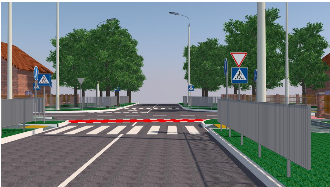
Рис. 3.9. Облаштування пішохідного переходу
