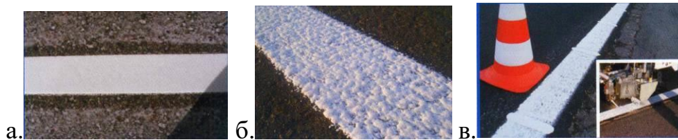
Рис. 2.12. Горизонтальна розмітка: а – гладкого суцільного нанесення; б – структурного нанесення; в – структурне нанесення з “багетами”
