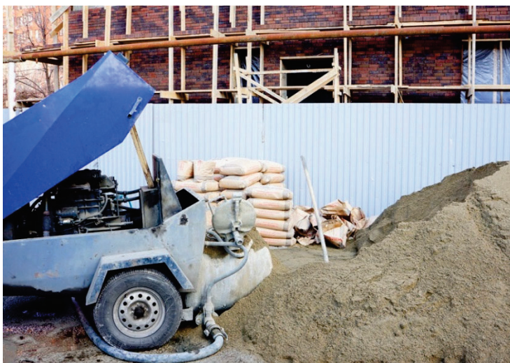
Рисунок 1 – Робоче місце оператора-машиніста (змішувач-пневмонагнітач)
