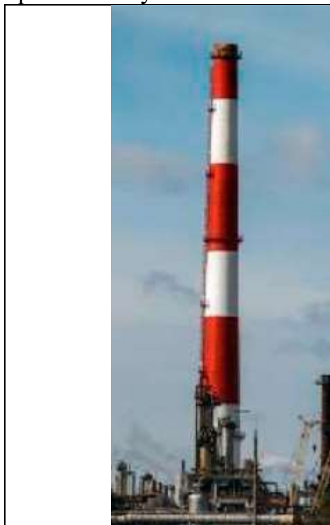
Рис. 3. Димова труба з монолітного залізобетону [16]
