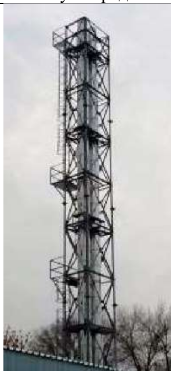
Рис. 4. Металева труба яка підтримується жорсткою просторовою конструкцією [16]
