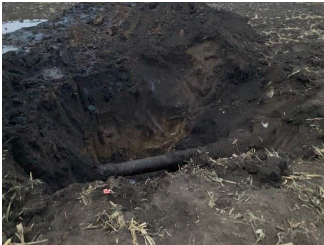
Рисунок 1.2 Аварійний розрив нафтопроводу в Охтирському районі Сумської області
