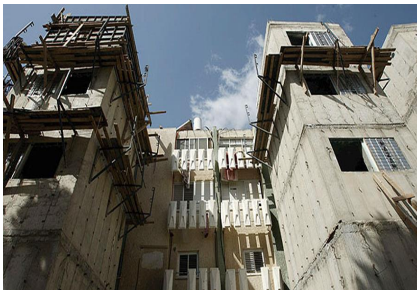
Рис. 1.6 Будівництво багатоквартирного будинку з мамадом.
