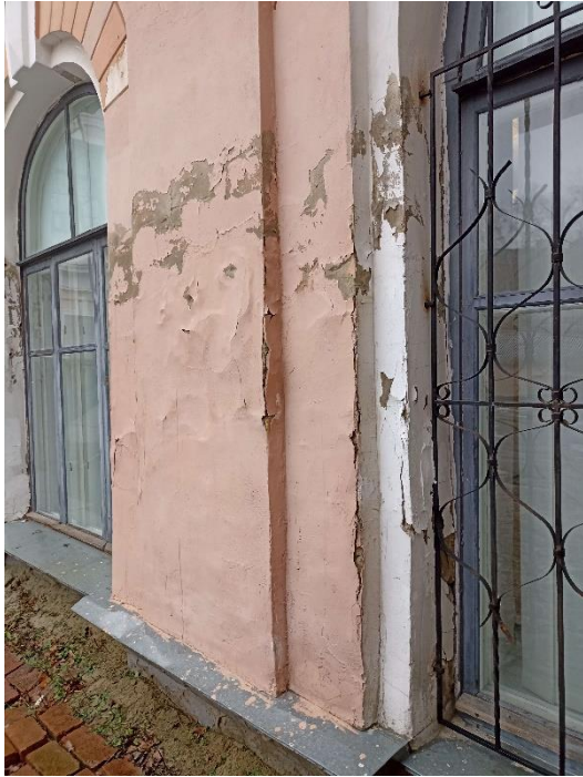
Рисунок а) відшарування штукатурки в прифундаментній зоні зовнішніх стін та утворення грибка; б) тріщини на колонах та барильєфах. 1. Дефекти конструкцій стін: а) відшарування штукатурки в прифундаментній зоні зовнішніх стін та утворення грибка; б) тріщини на колонах та барильєфах.
