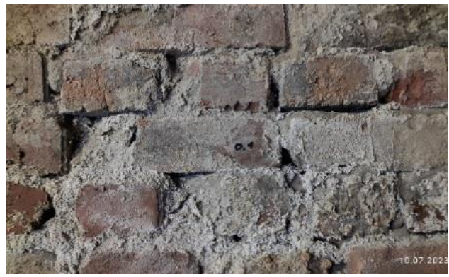
б) висоли на кладці стін (стан «2»)
