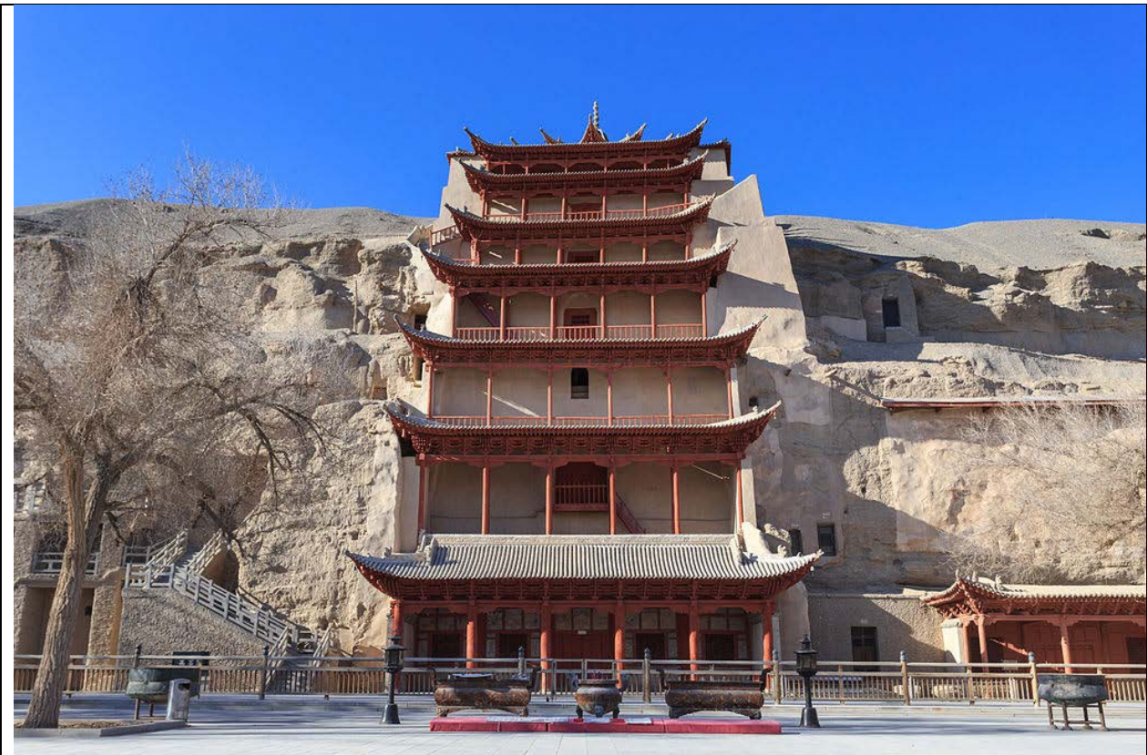
Рис.1 – Вхід в комплекс Дуньхуана.
