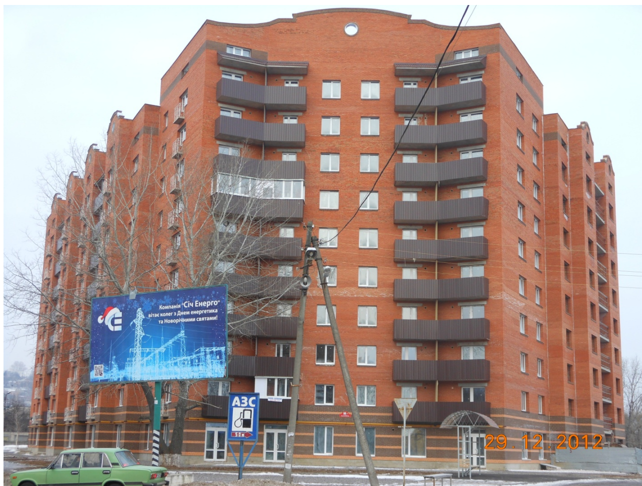
Рис. 3.1. Об'єкт дослідження: будинок в м. Полтава по вул. Панянка, 65-Б
