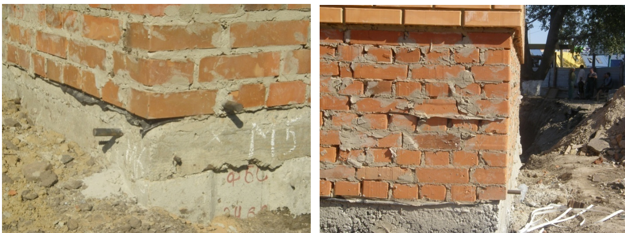
Рис. 3.8. Стінові осадові марки, влаштовані на об'єкті досліджень
