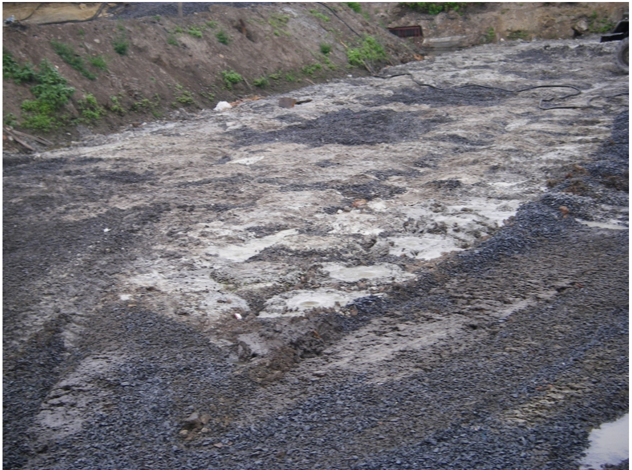
Рис. 3.6. Армована ґрунтоцементними елементами основа
