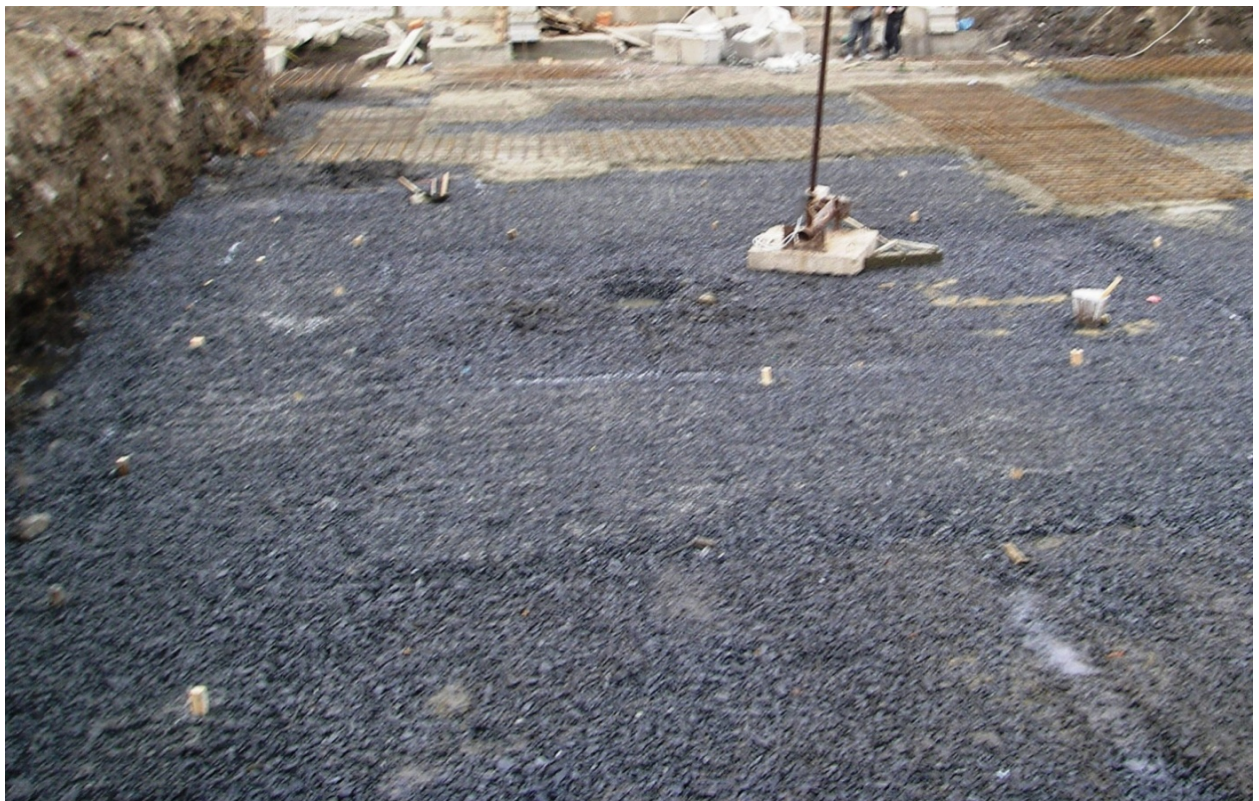
Рис. 3.7. Улаштування щебеневої підготовки (буферного шару)
