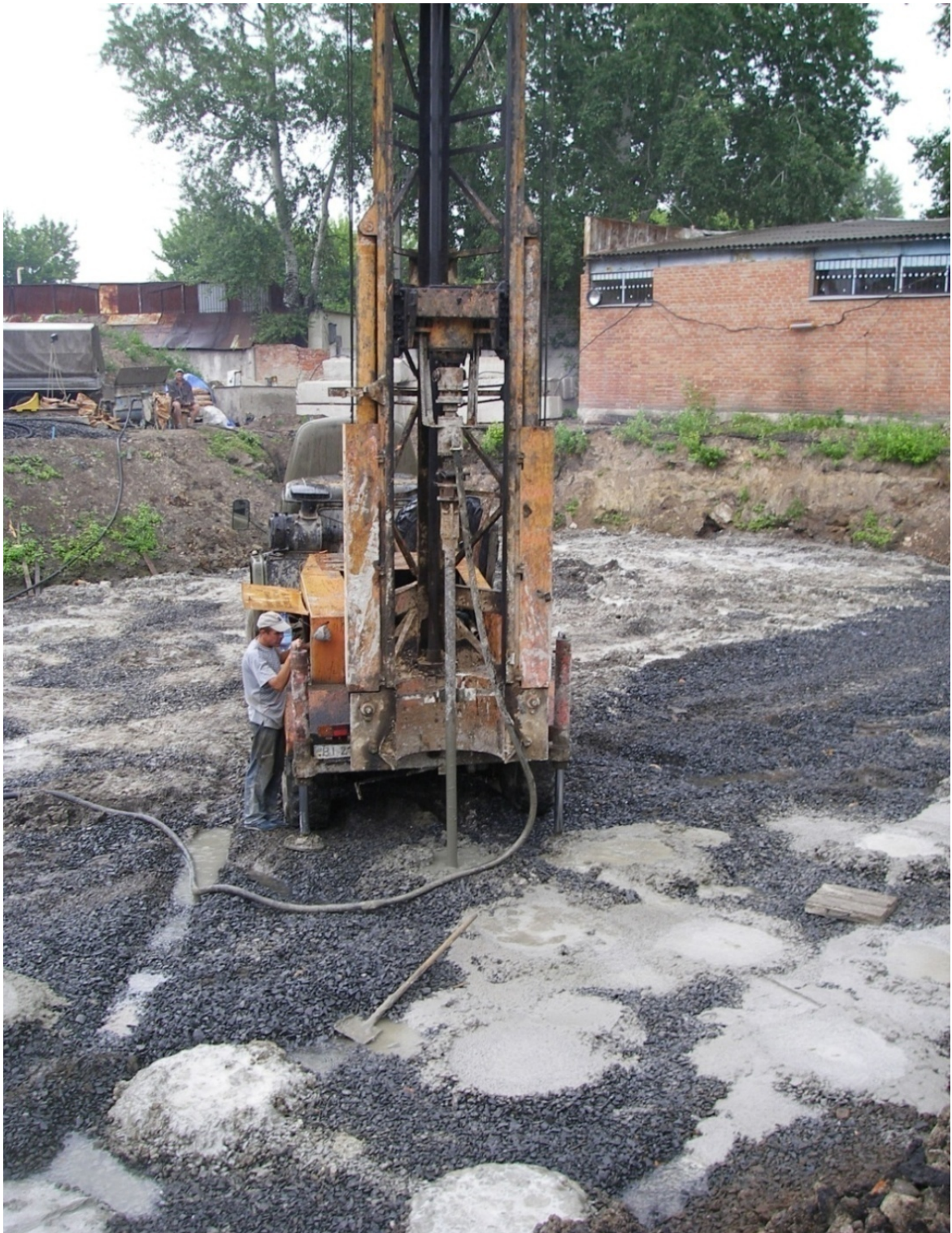
Рис. 3.5. Армування несучого шару основи об'єкта вертикальними жорсткими ГЦЕ, виготовленими за бурозміщувальною технологією
