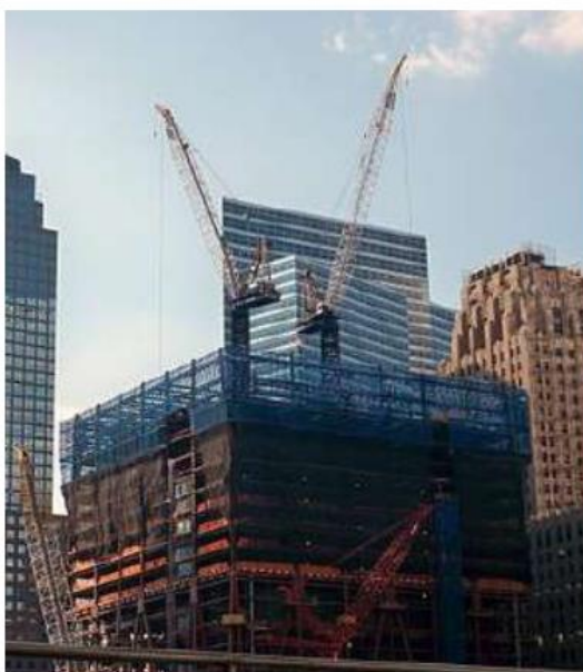
Рисунок 2 – Будівництво хмарочоса у Нью-Йорці
