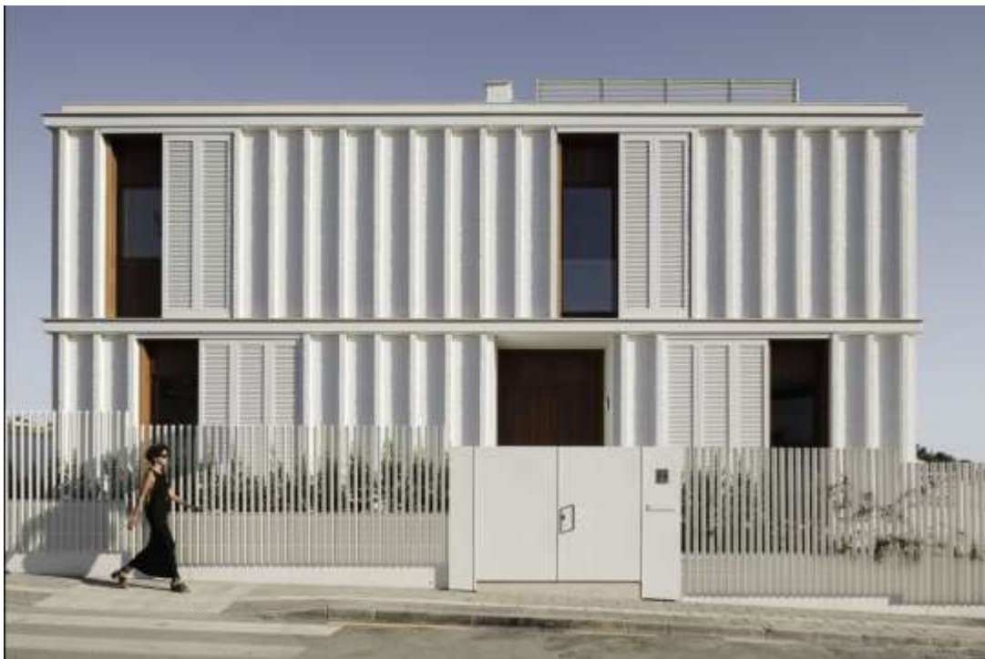
Рис. 4.30. Огорожа своєю структурою та кольором підтримує архітектуру будівлі демонструючи свою невід’ємність від неї
