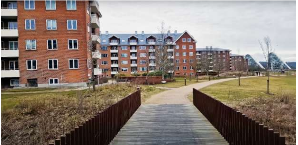
Рис. 4.25. Низька огорожа без поручня на містку через авраг у житловому районі міста Вайле, Данія
