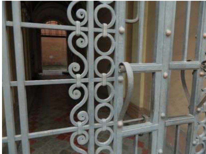
Рис. 2.14. З'єднання фігурних елементів за допомогою хомутиків
