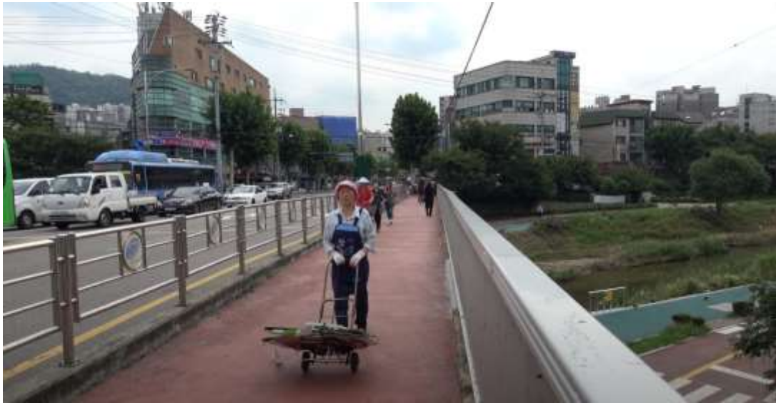
Рис.4.14. Низька огорожа із неіржавіючої сталі на мосту у місті Сеул, Південна Корея
