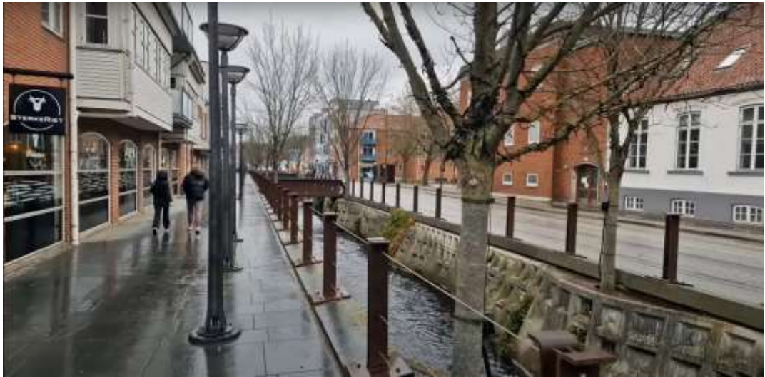
Рис. 4.20. Огорожа з кольорового металу між тротуаром та каналом, м. Вайле, Данія
