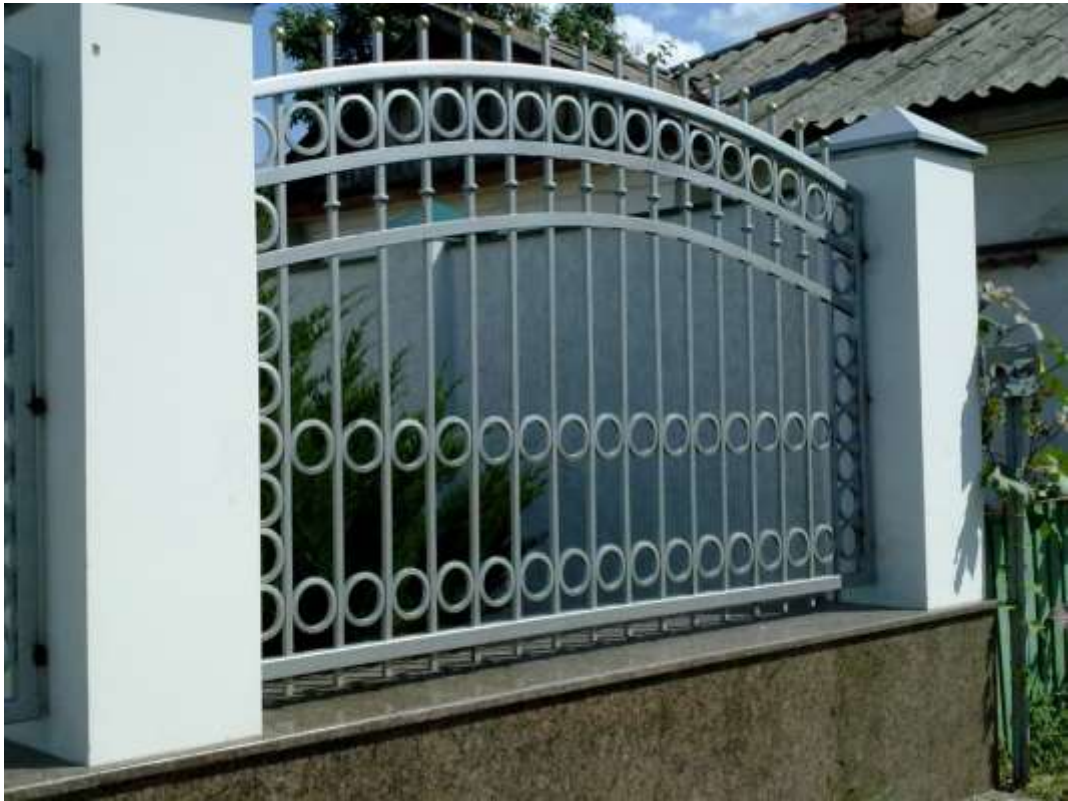
Рис. 2.12. Застосування квадратної труби для формування контуру ланки, м. Полтава
