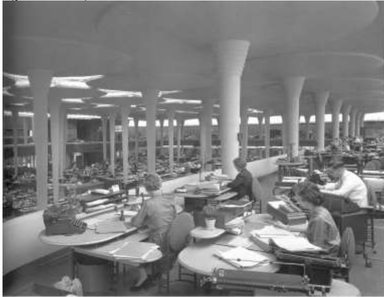
Рис. 9.23. Насичені обладнанням робочі місця у офісному приміщенні фірми «Джонсон и Фокс», м. Расін, шт. Вісконсін, США, 1936 -1939рр. Арх. Ф.Л. Райт
