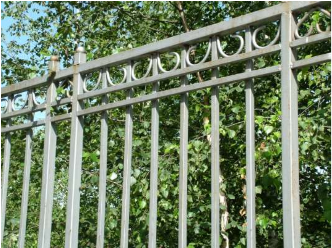
Рис. 1.5. Огорожа, виконана з використанням квадратної металевої труби
