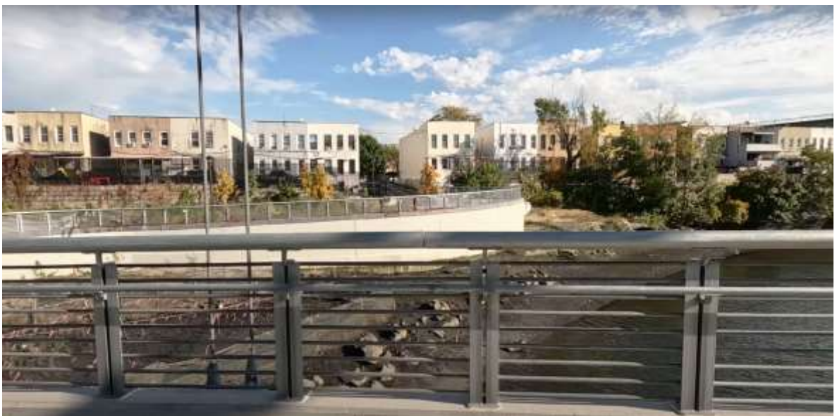
Рис. 4.13. Низька огорожа з кольорового металу на мосту у районі Бронкс, м. Нью-Йорк, США
