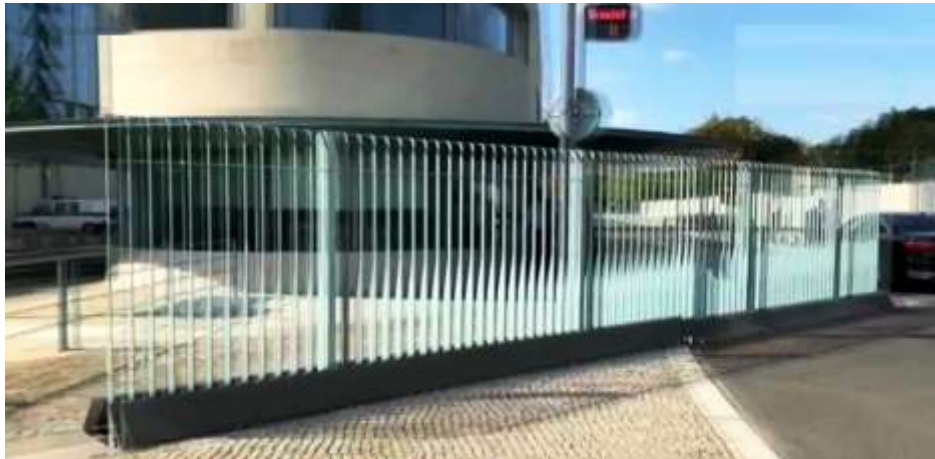
Рис. 3.29. Огорожа з відсутніми горизонтальними тягами, що уладнює її подолання, Німеччина
