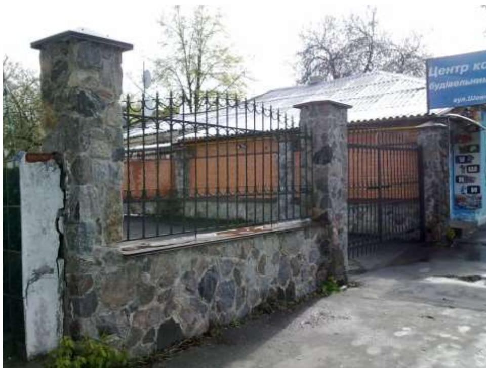
Рис. 2.1. Металева огорожа з кам'яними опорами
