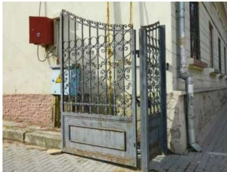
Рис. 3.4. Металеві ворота у двір житлового будинку
