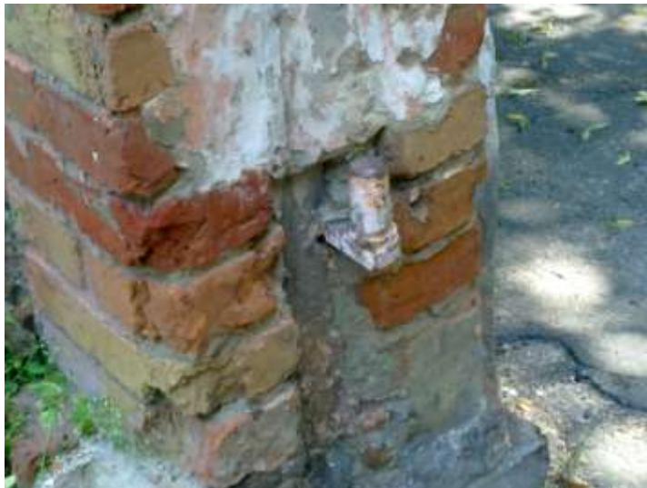
Рис. 3.13. Консоль зі стрижнем, прикріплена до металевої стійки, обкладеної цеглою
