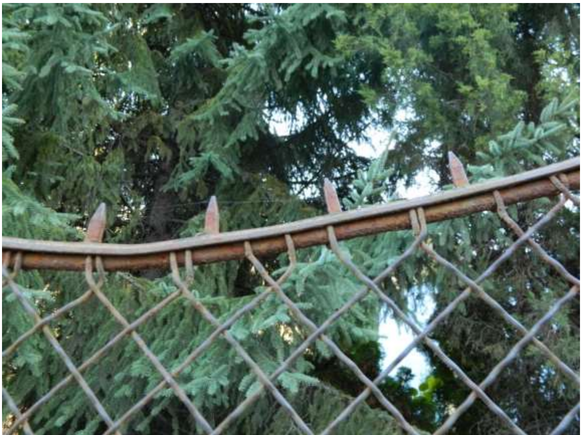
Рис. 2.16. Приєднання завершення ланок до несучої рами секції, м.Чернівці
