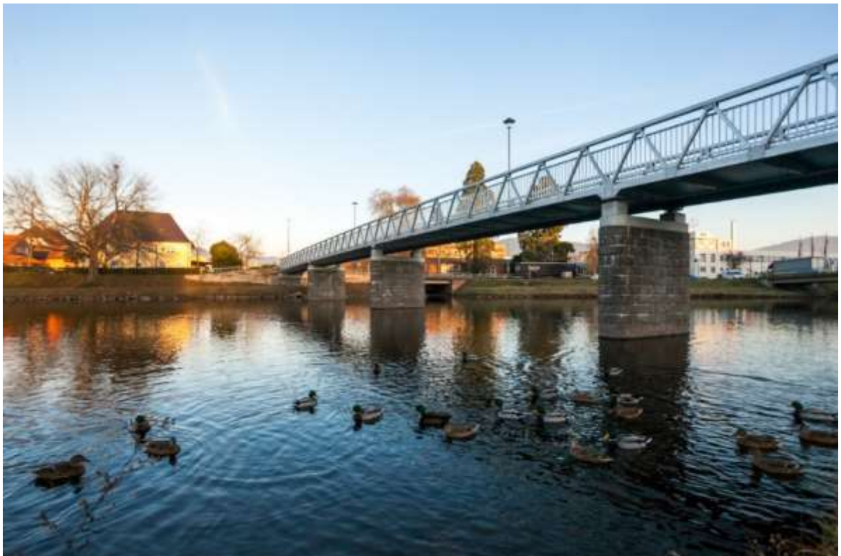
Рис. 4.9. Міст та низька огорожа із кольорового металу
