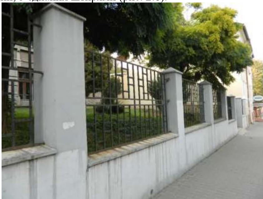
Рис. 2.3. Огорожа із цегляними оштукатуреними опорами
