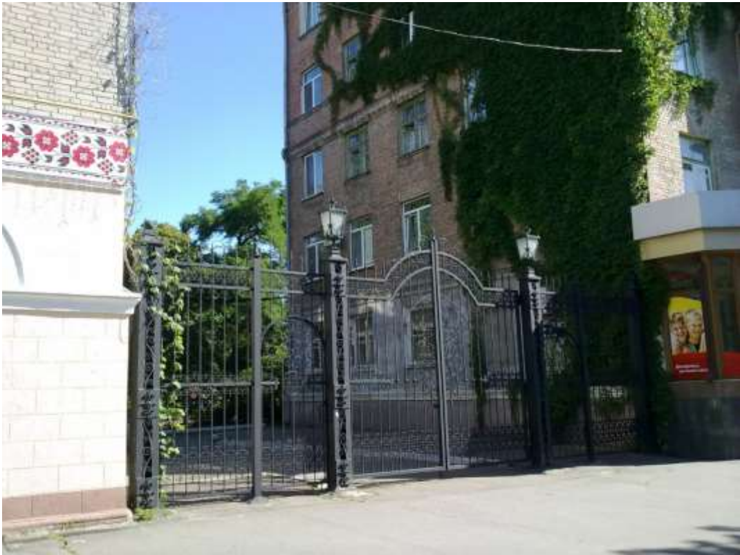
Рис. 2.8. Огорожа з металевими опорами у вигляді просторової конструкції, м. Кременчук
