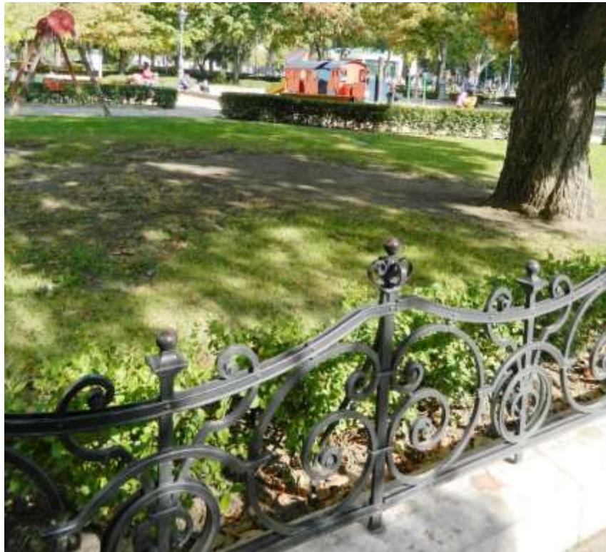
Рис. 4.44. Штахетник з сортової сталі у сквері в історичній частині м. Відень, Австрія
