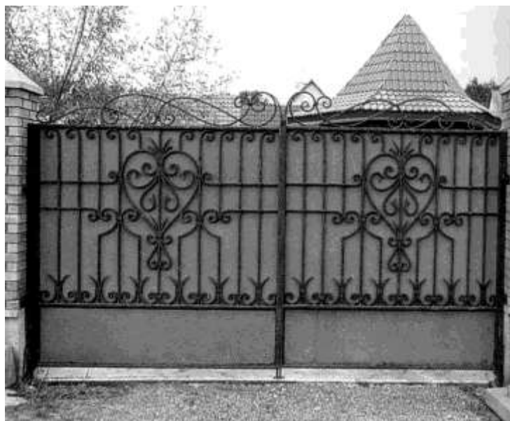
Рис. 3.5. Приклад воріт з металевих прокатних профілів закритих металевим листом
