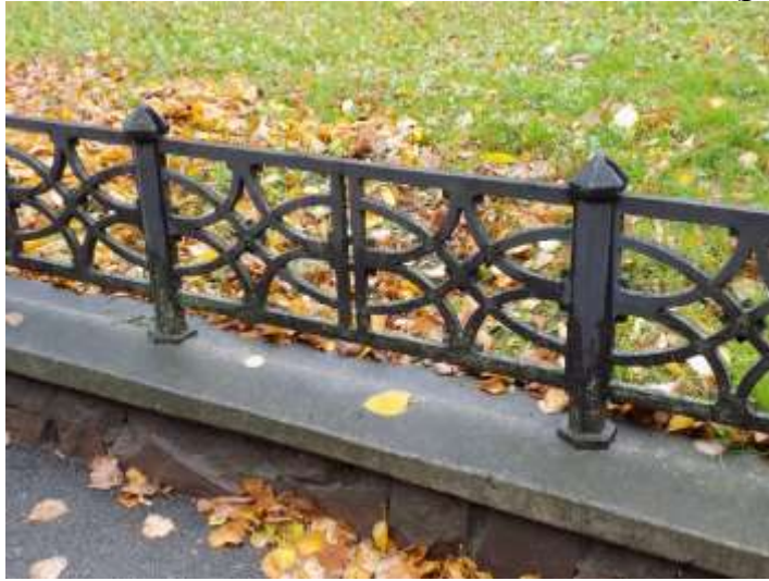
Рис. 4.36. Секції чавунного штахетника, розташовані на цоколі з природного каменю та бетону, м. Івано-Франківськ
