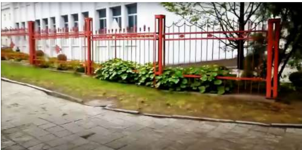
Рис. 4.33. Червоний колір високої огорожі разом із зеленню рослин створює виразну картину середовища
