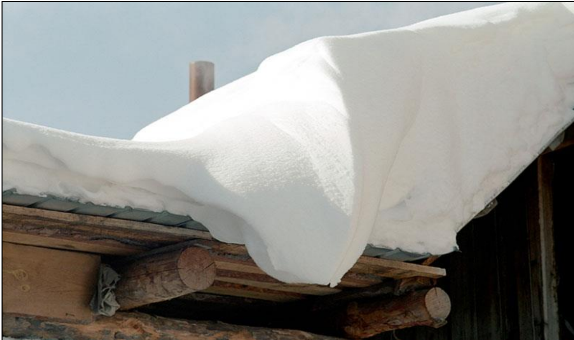
Рис. 10.10. Відкладення снігу в єндовах покрівель
