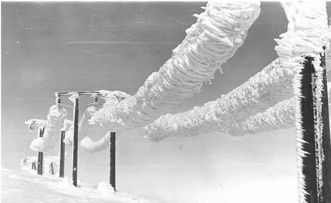
Рис. 15.1. Небезпечний вплив ожеледі: а – руйнування опори ПЛ від ожеледного навантаження; б – обледеніння електричних дротів
