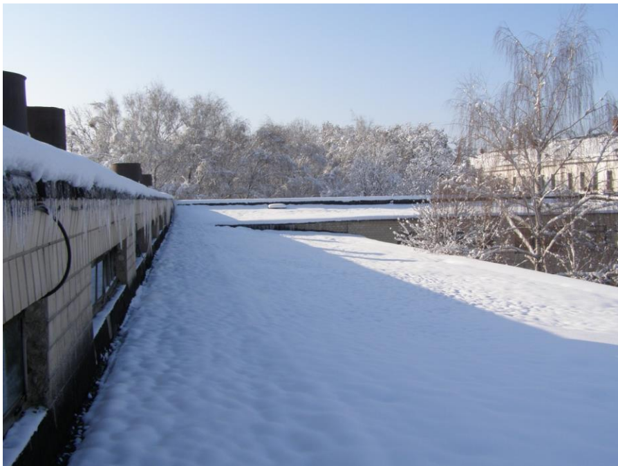
Рис. 10.7. Сніговий покрив на тепловиділяючій покрівлі
