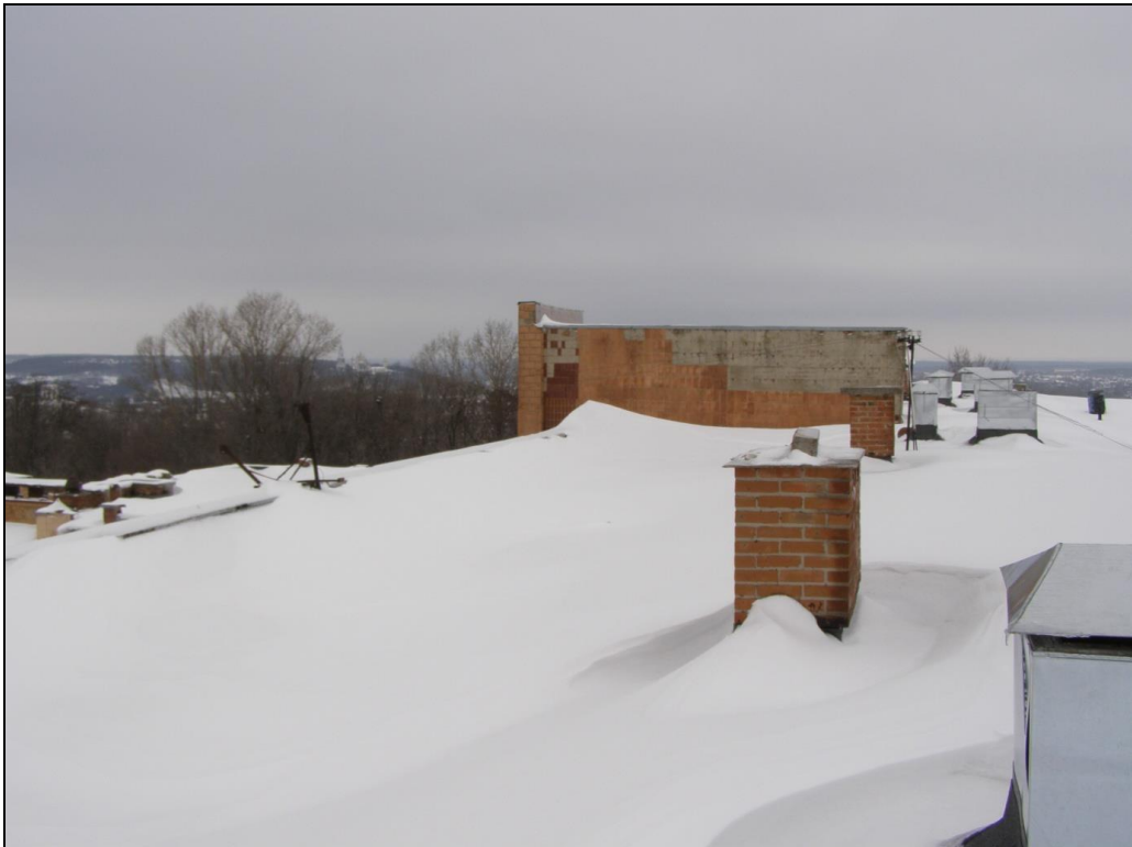
Схема 11. Ділянки покриттів, що примикають до вентиляційних шахт, які вивищуються над покрівлю, та інші надбудови
