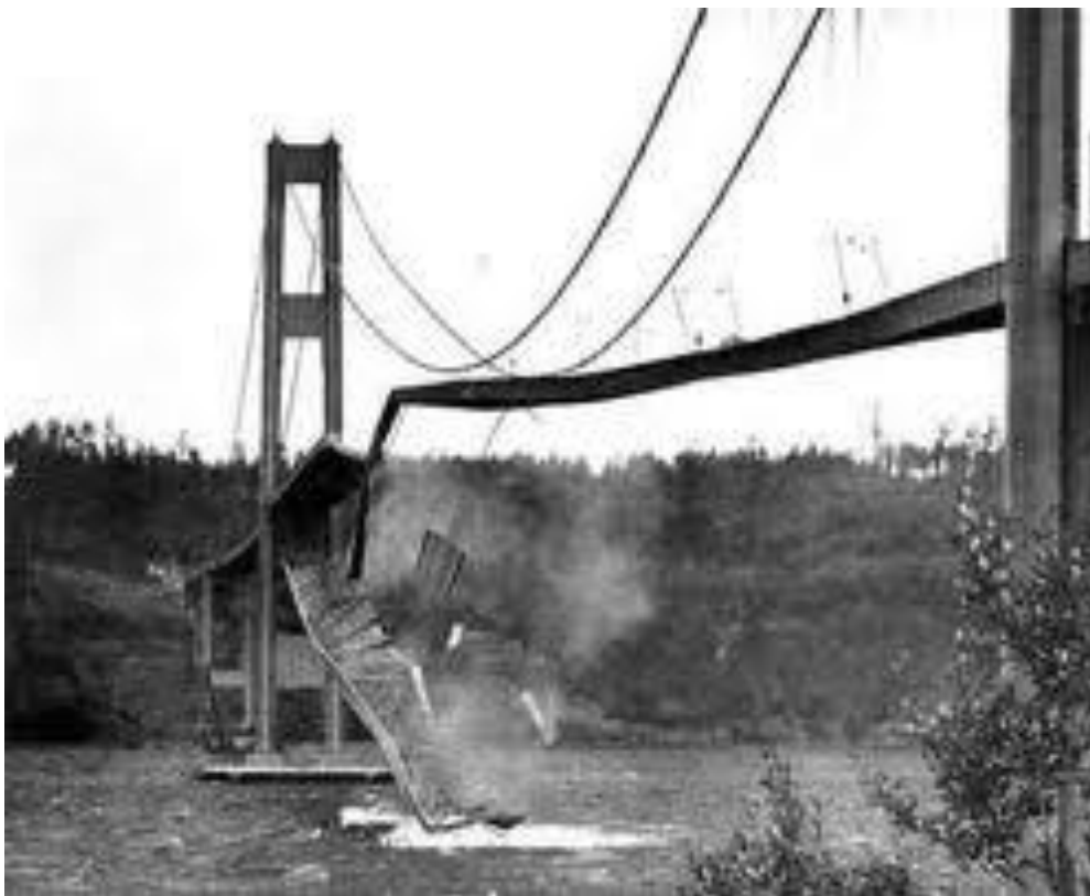
Рис. 3.2. Руйнування Такомаського моста: а – початок розхитування; б – характер руйнування моста
