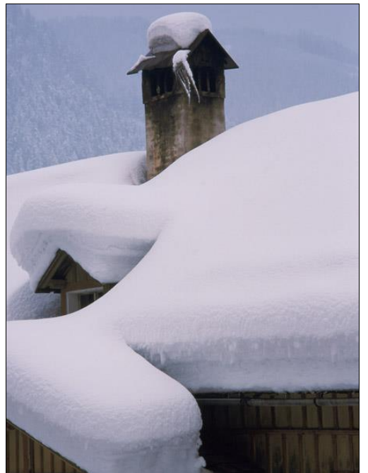
Рис. 10.8. Снігове навантаження на похилих покриттях
