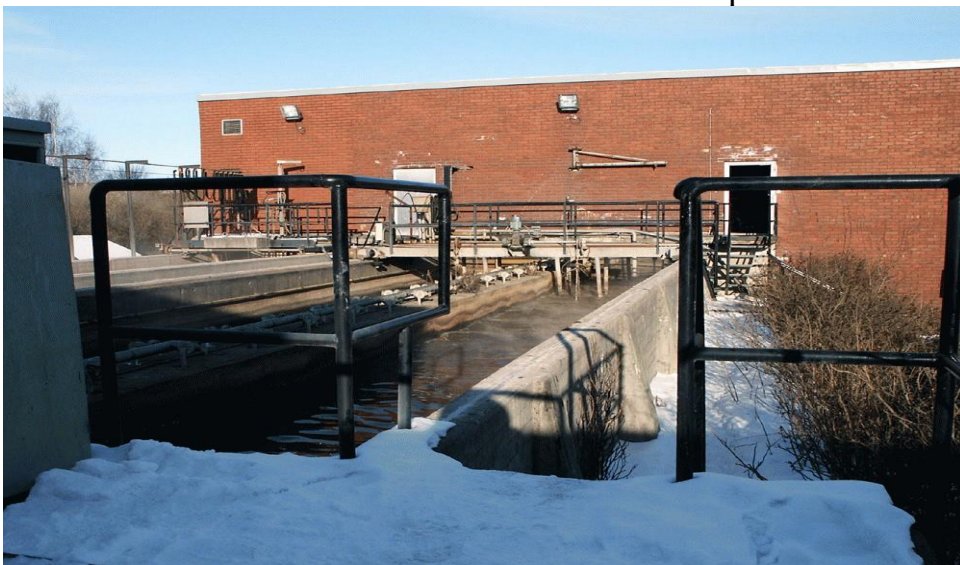
Рис. 2.8 Горизонтальний аераційний пісковловлювач
