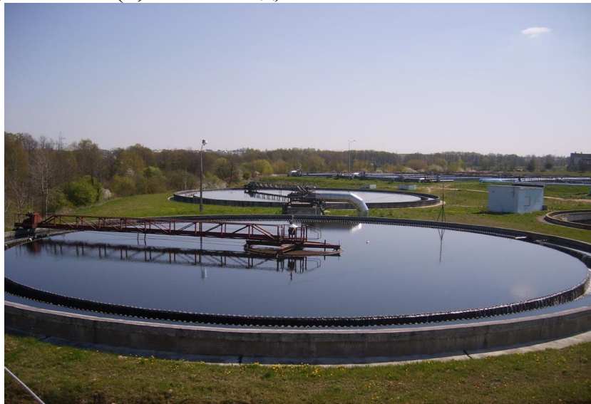
Рис. 2.10 Радіальний відстійник
