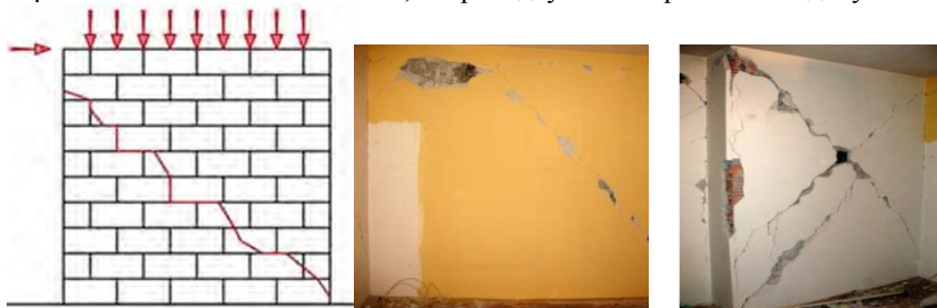
Рис.1. Характер руйнування цегляної кладки при сумісній дії вертикальних і горизонтальних навантажень шляхом діагонального зсуву
