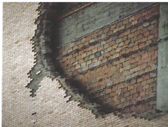
Рисунок 2.10 - Відшарування облицювання кладки, що не перев'язана з основною кладкою стіни
