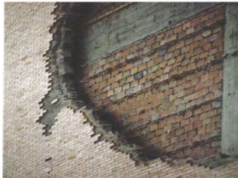
Відшарування облицювання кладки, котра не перев'язана з основною кладкою стіни
