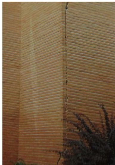
Рисунок 2.9 - Приклад відшарування лицьової кладки фасаду
