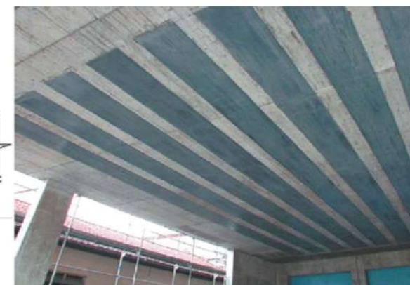
Підсилення залізобетонної плити стрічками фірми Sika
