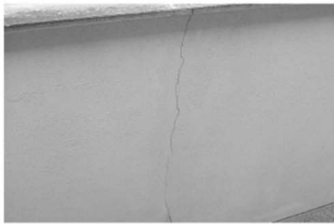
Розтріскування кладки внаслідок усадки вологи
