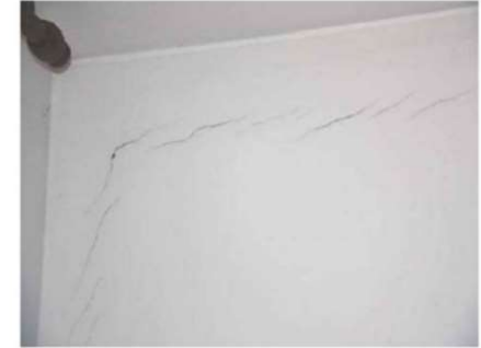
Тріщини в кладці внаслідок температурних деформацій плит даху
