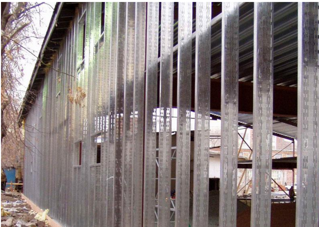
Рисунок 1.9 – Зовнішня огорожувальна конструкція, виконана із ЛСТК
