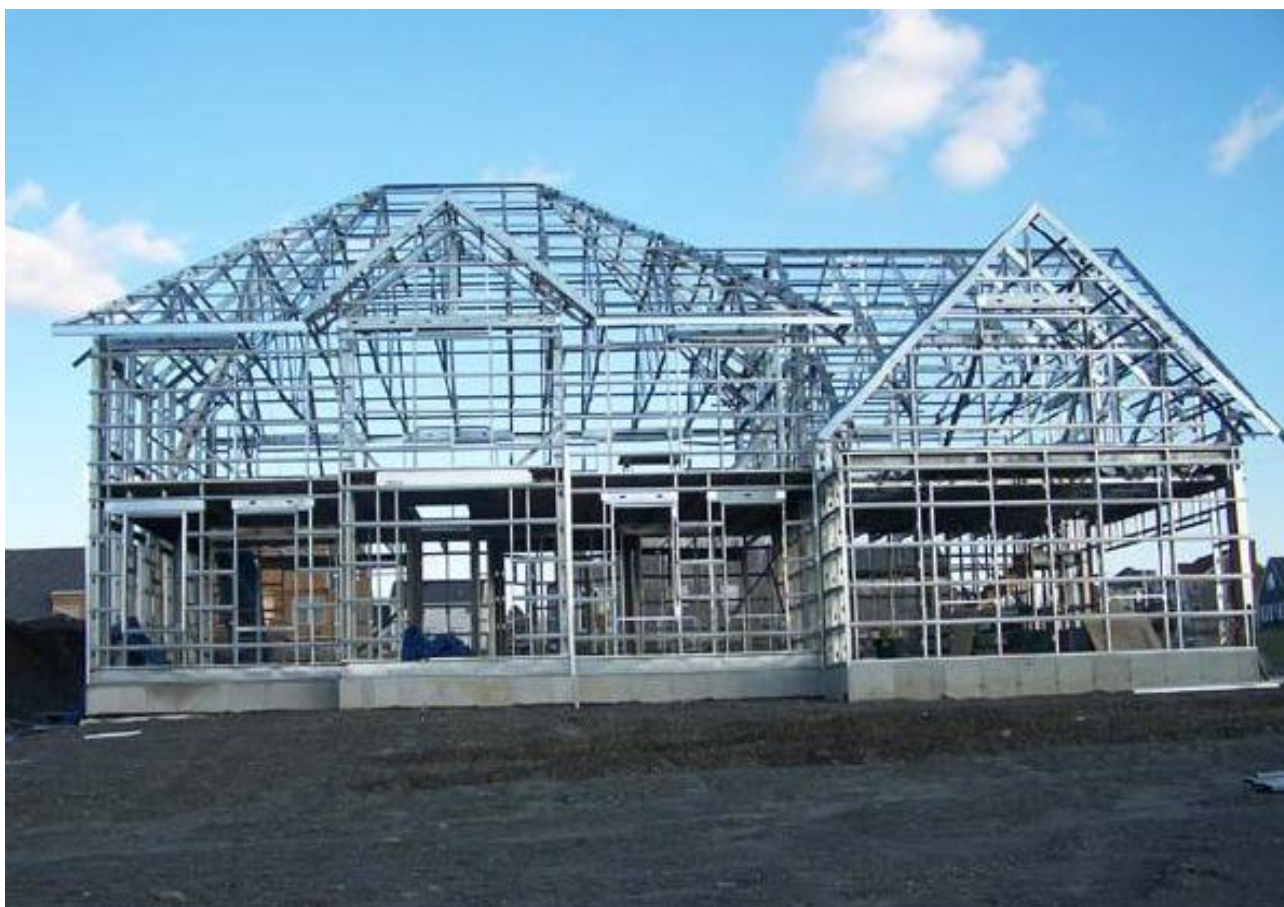
Рисунок 1.6 – Каркас двоповерхового житлового будинку із ЛСТК
