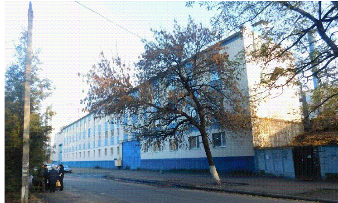
Загальний вигляд переходу на третій поверх та до сусідньої виробничої будівлі
