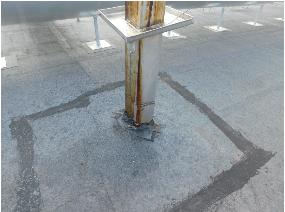
Рис. 3.8 Негерметичність виводу комунікацій на покрівлю
