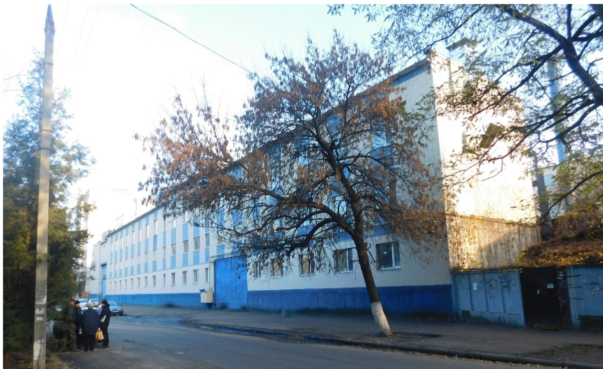
Рис. 2.3. Загальний вигляд фасаду виробничої будівлі в осях 8-1
