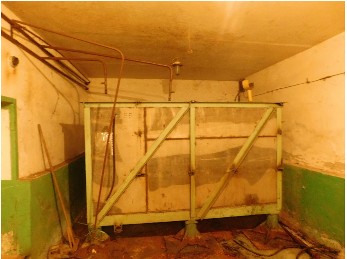
Рис. 1.4. Загальний вигляд підвального приміщення в осях 1-2
