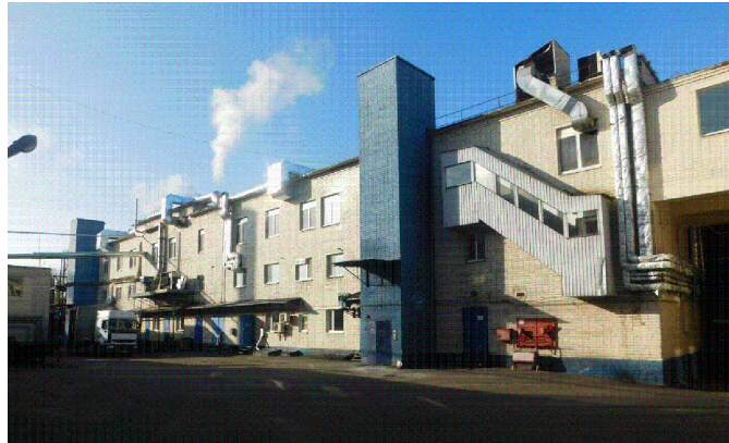
Загальний вигляд фасаду виробничої будівлі в осях 8-1
