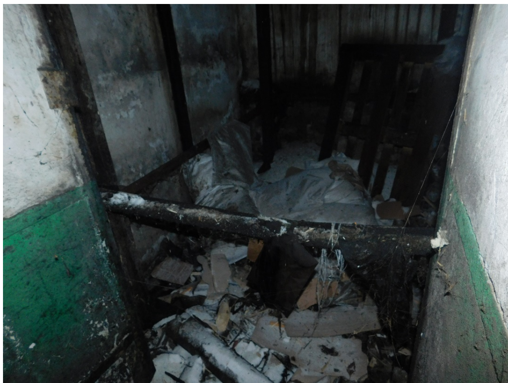
Рис. 3.6 Сміття у ліфтовій шахті на рівні підвалу в осях 1-2
