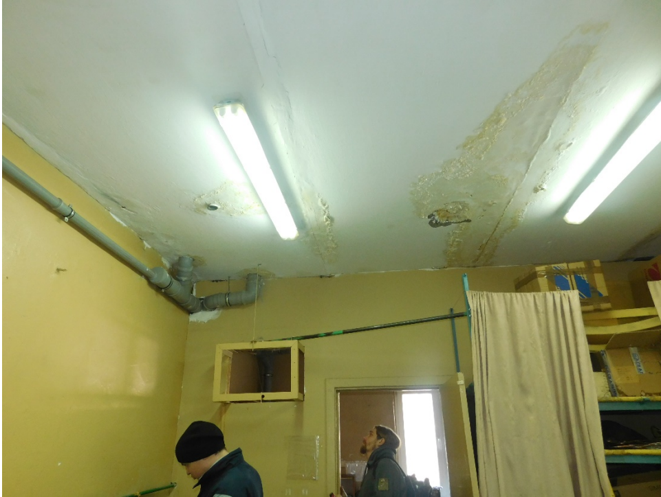
Рис. 3.7 Протікання сантехнічних приладів на верхньому поверсі
