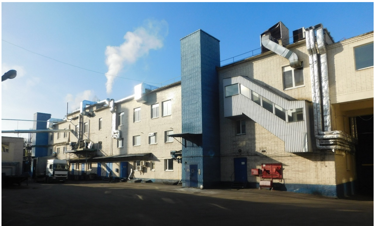
Рис. 2.2. Загальний вигляд фасаду виробничої будівлі в осях 1-8
