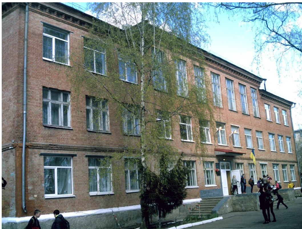
Рисунок 2.1 – Фасад будівлі школи із сторони головного входу в осях А-И/1 (вид від осі А/1). У центральній частині третього поверху – актовий зал
