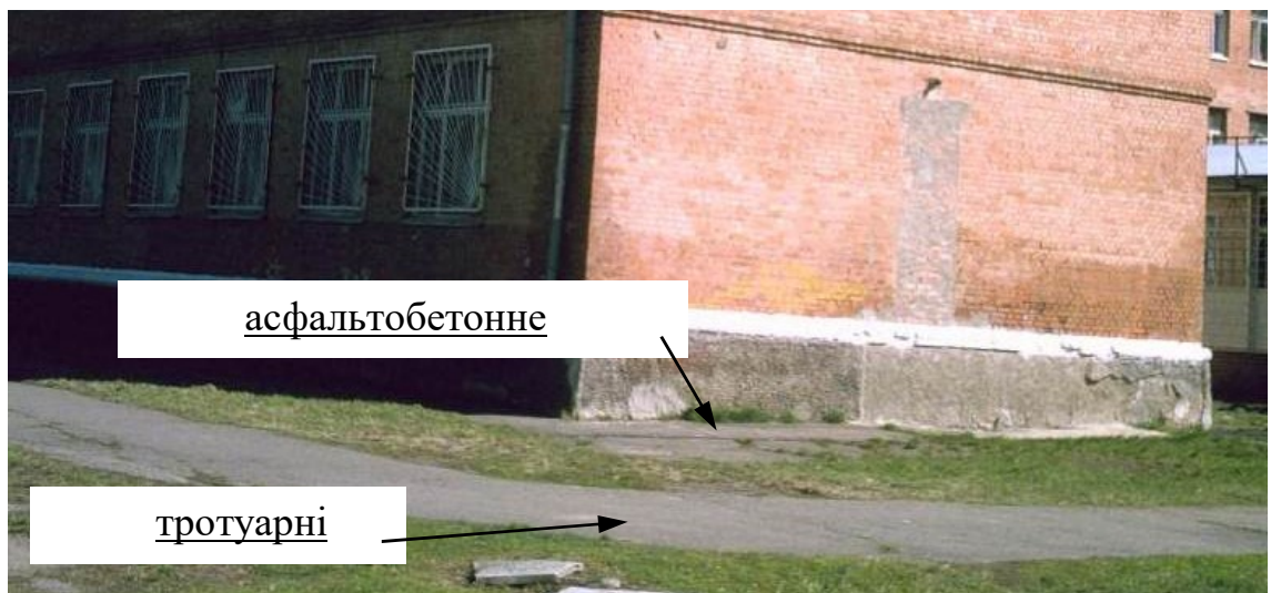
Рисунок 2.12 – Загальний вигляд влаштування вимощення і тротуарів навколо будівлі школи
