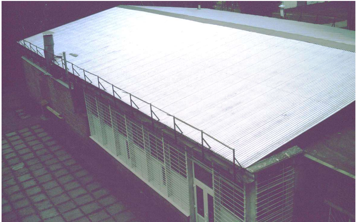
Рисунок 2.14 – Загальний вигляд покрівлі над приміщеннями їдальні
