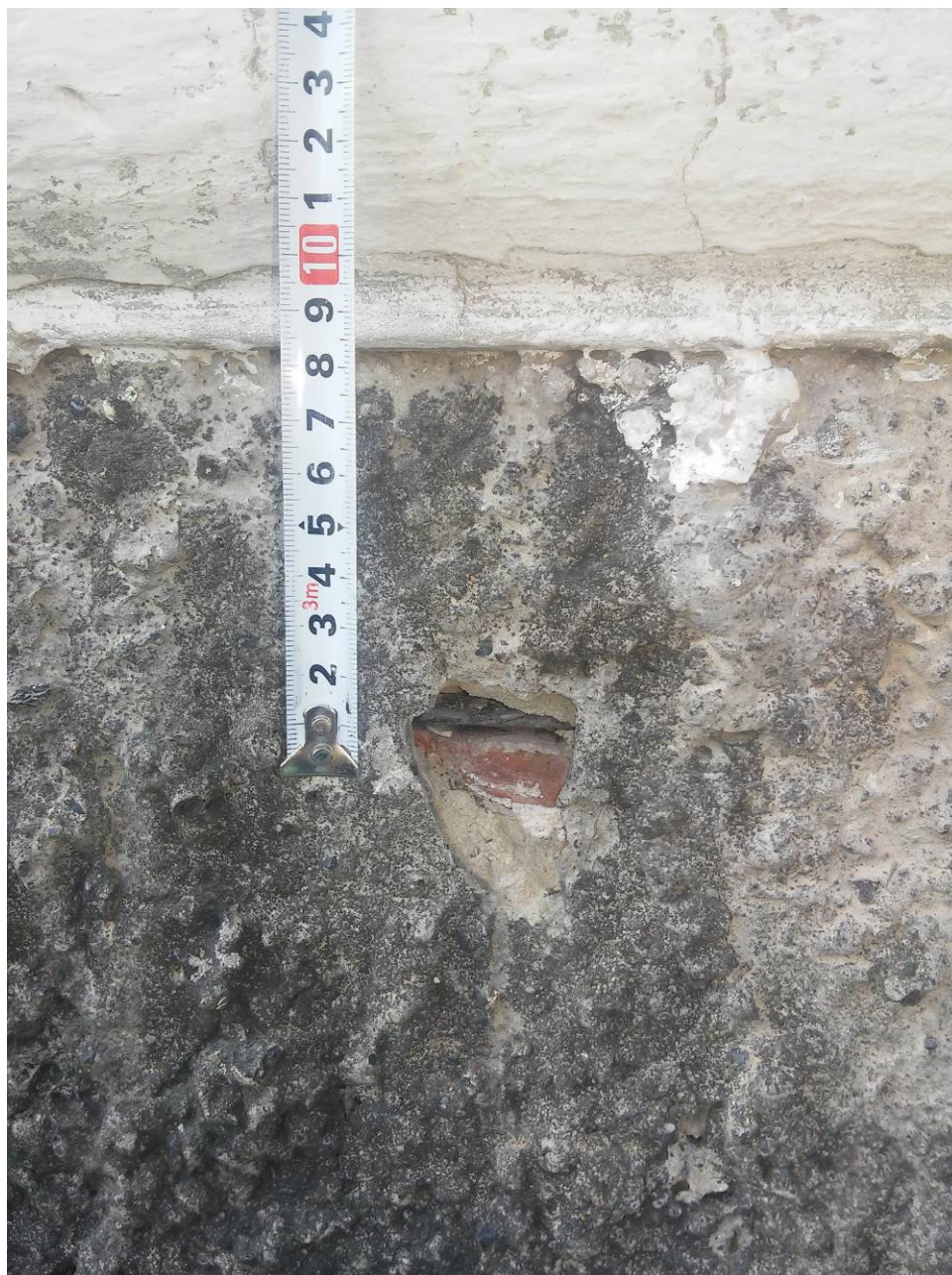
Рисунок 3.11 - Фото гідроізоляції в зовнішній стіні
