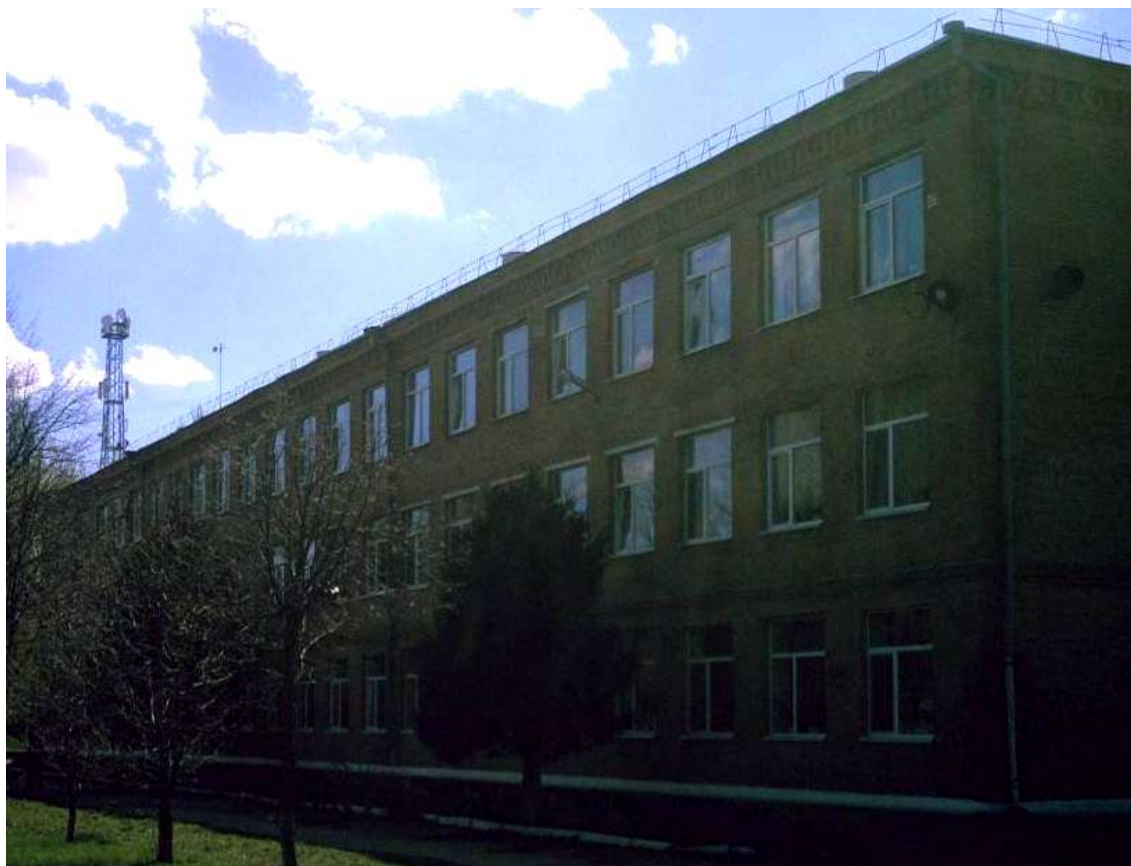
Рисунок 2.2 – Фасад зі сторони центральної частини будівлі в осях 1-12/И (вид від осі И/12). На всіх поверхах розташовані учбові класи
