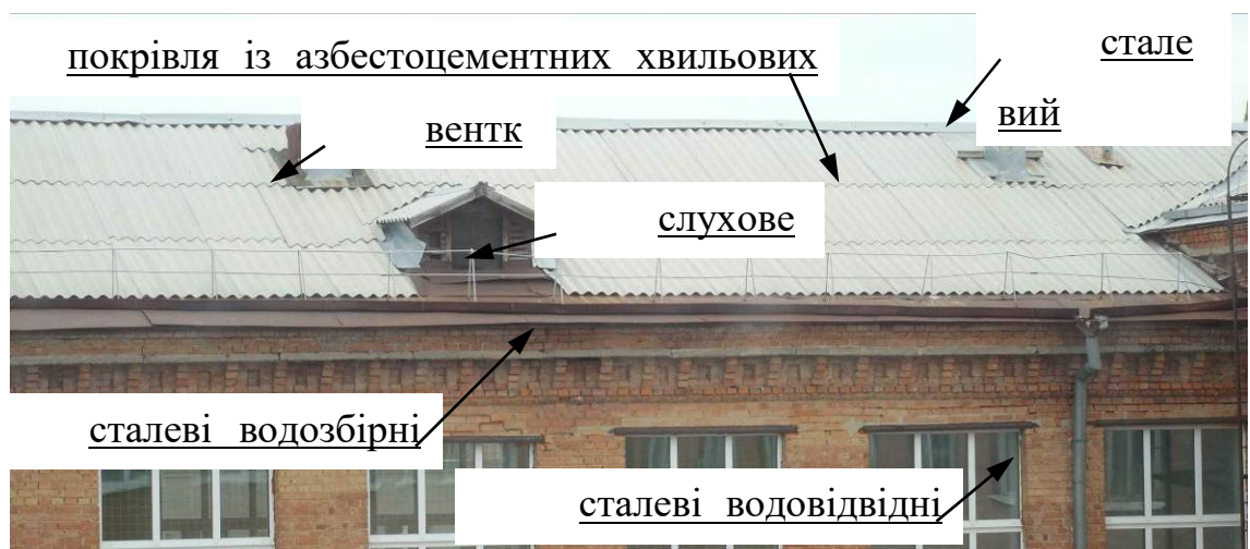
Рисунок 2.11 – Загальний вигляд влаштування покрівлі основної частини будівлі
