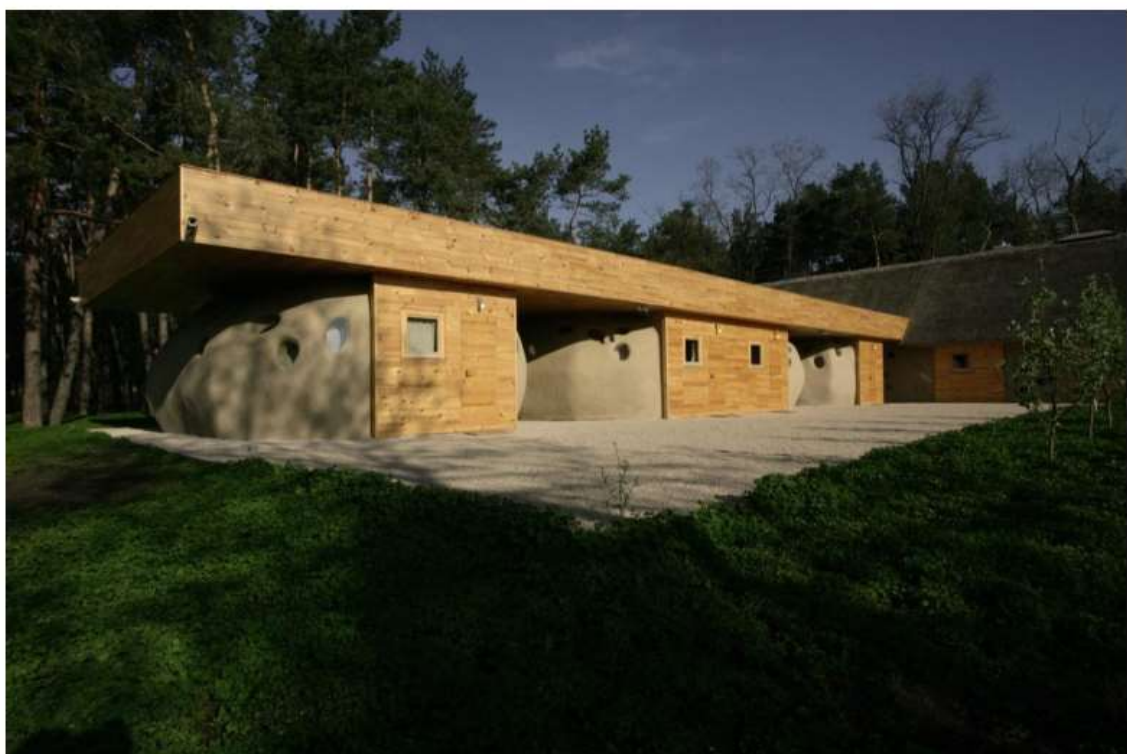
Рис.1.4 Зовнішній вигляд споруди
