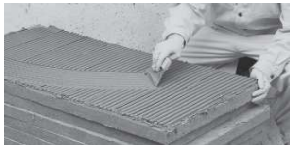
Малюнки 72,73 (спосіб нанесення розчину)
