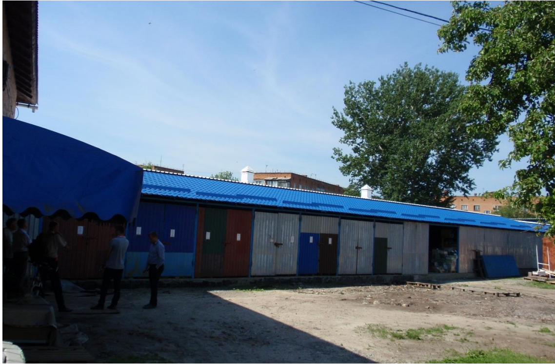
Рис. 1.10 – Загальний вигляд будівлі в осях 9-1
