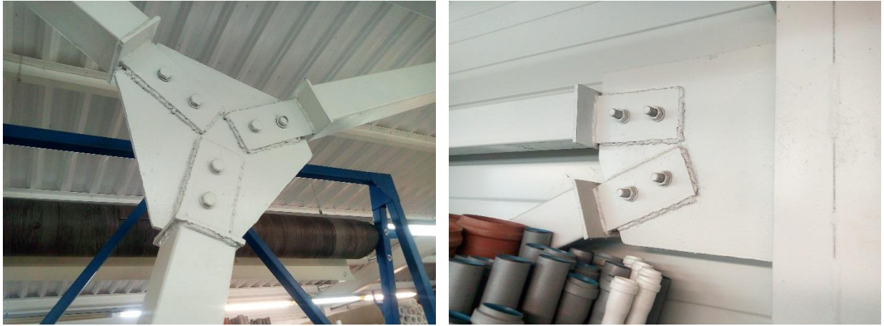
Рис. 1.13 – Обварка елементів при залишених монтажних болтах каркасу будівлі А
