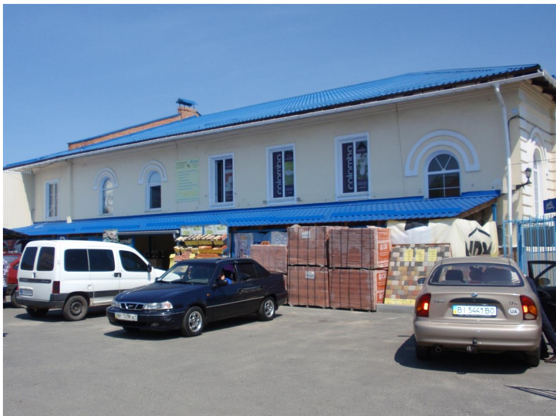
Рис. 1.3 – Загальний вигляд будівлі в осях 7-1
