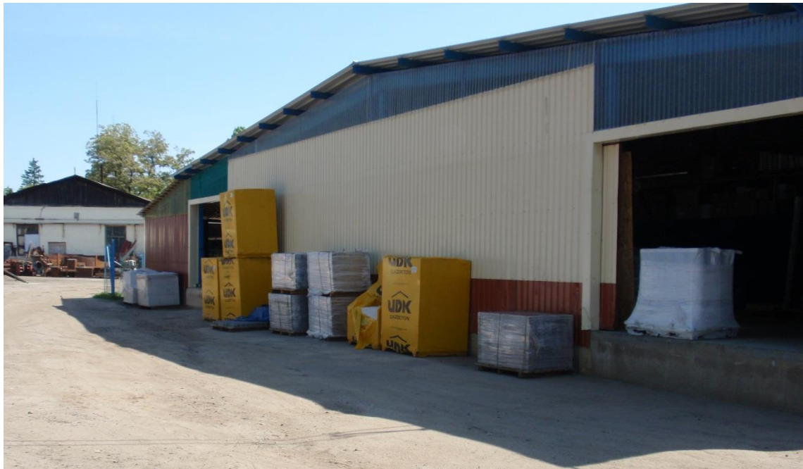
Рис. 1.9 – Загальний вигляд будівлі в осях Д-А
