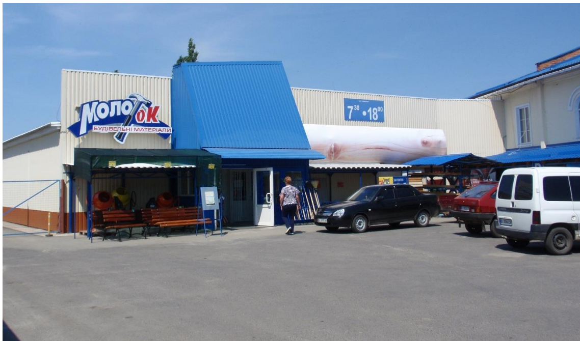
Рис. 1.7 – Загальний вигляд будівлі в осях А-Д
