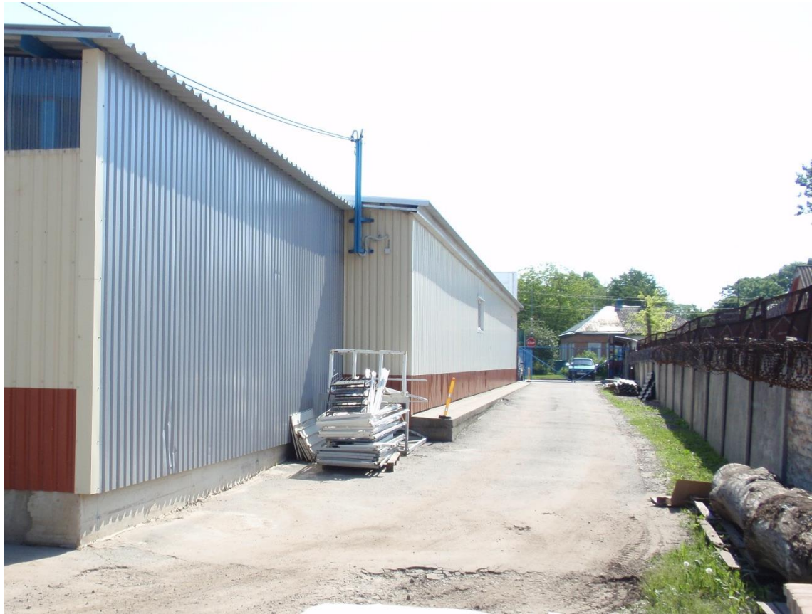
Рис. 1.8 – Загальний вигляд будівлі в осях 1-9
