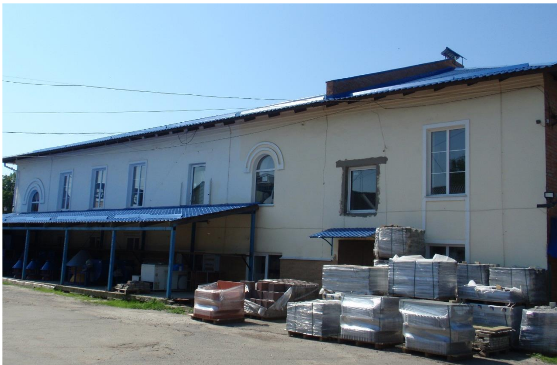
Рис. 1.5 – Загальний вигляд будівлі в осях 1-7
