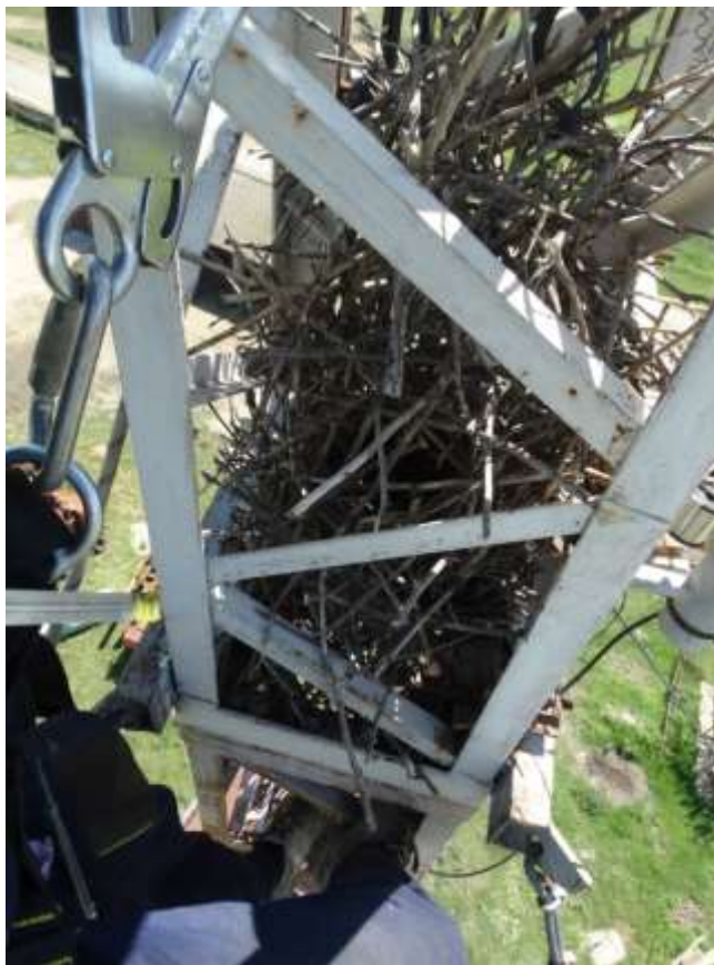
Рисунок 2.2 – Приклад виконання секції з кутиків
