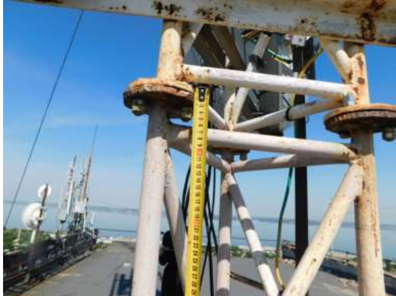
Рисунок 2.1 – Приклад виконання секції з труб
